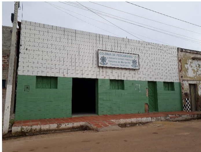
Figura V.3.3.1-5 - Fachada da Colônia de Pescadores de Caiçara do Norte Z-01.
