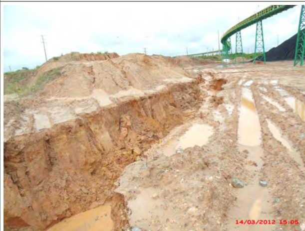
Foto 15 C: Erosão causada pelo problema do sistema de drenagem do Pátio de carvão e falta de manutenção da área.
