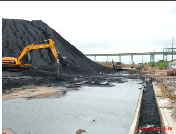
Foto 09 C: Transbordo da drenagem do Pátio de Carvão em função da obstrução das canaletas de drenagem.
