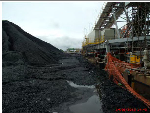
Foto 03 C: Carvão obstruindo as canaletas de drenagem.
