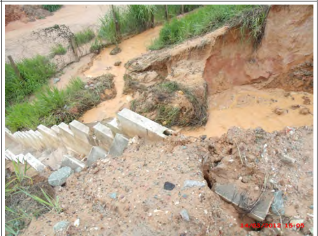
Foto 16 C: Erosão causada pelo problema do sistema de drenagem do Pátio de carvão e falta de manutenção da área.
