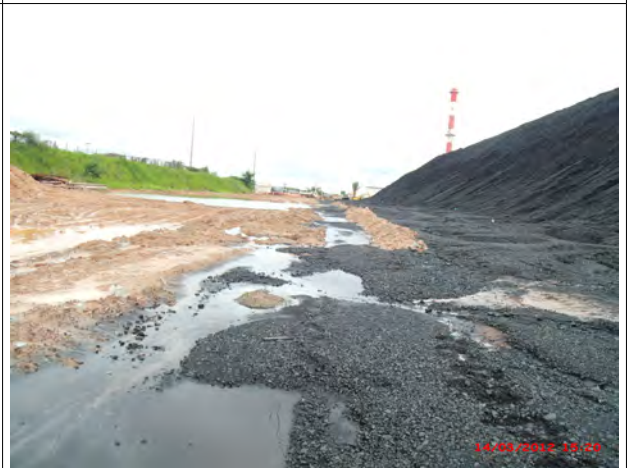
Foto 10 C: Transbordo da drenagem do Pátio de Carvão em função da obstrução das canaletas de drenagem.
