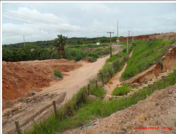
Foto 13 C: Transbordo da drenagem do Pátio de Carvão em função da obstrução e não isolamento das canaletas de drenagem.
