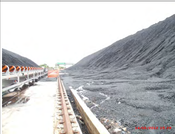
Foto 07 C: Transbordo da drenagem das pilhas de carvão para área externa ao Pátio em função da obstrução das canaletas e vertedouros erroneamente voltados para a área afetada.
