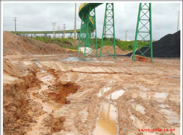
Foto 16 C: Erosão causada pelo problema do sistema de drenagem do Pátio de carvão e falta de manutenção da área.
