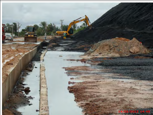
Foto 02 C: Água de drenagem do Pátio de Carvão e isolamento da tubulação que o conecta à Bacia 71 e/ou RIP RAP 2.
