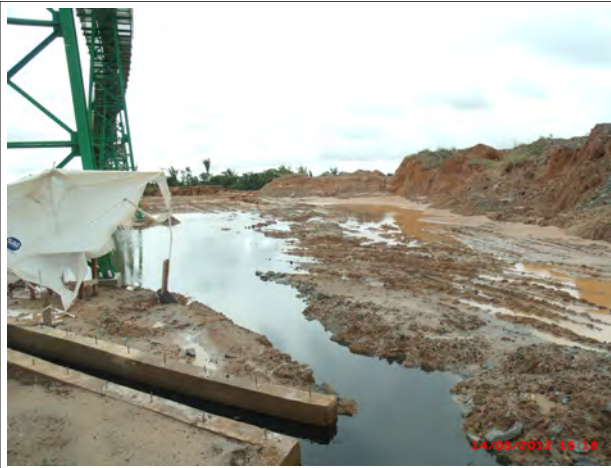
Foto 13 C: Transbordo da drenagem do Pátio de Carvão em função da obstrução e não isolamento das canaletas de drenagem.
