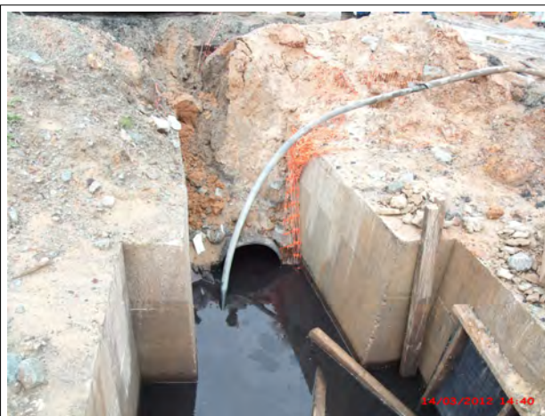
Foto 02 C: Água de drenagem do Pátio de Carvão e isolamento da tubulação que o conecta à Bacia 71 e/ou RIP RAP 2.
