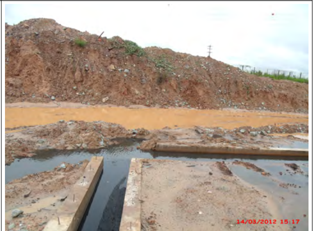
Foto 10 C: Transbordo da drenagem do Pátio de Carvão em função da obstrução das canaletas de drenagem.
