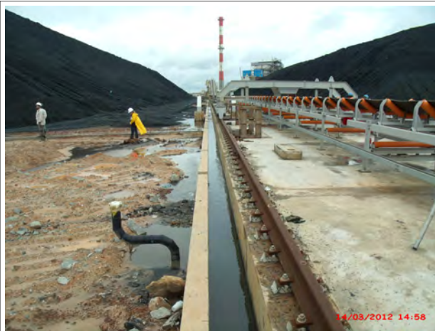
Foto 07 C: Transbordo da drenagem das pilhas de carvão para área externa ao Pátio em função da obstrução das canaletas e vertedouros erroneamente voltados para a área afetada.
