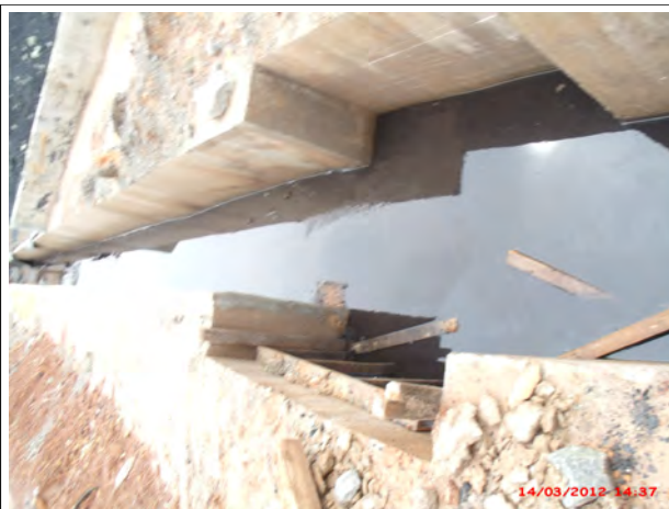
Foto 14 A: Obstrução da ligação das canaletas de Drenagem ao sistema de coleta.
