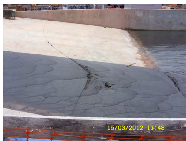
Foto 15 A: Transferência por caminhão pipa da drenagem do Pátio de Carvão para a Bacia 71, após bombeamento do efluente decantado.
