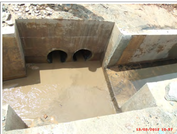
Foto 07 A: Integração das canaletas de drenagem dos Pátios de Carvão.
