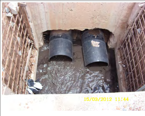
Foto 16 A: Liberação do Fluxo da drenagem do Pátio de Carvão para a Bacia 71, após bombeamento do efluente decantado.
