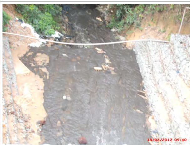
Foto 02 A: Drenagem do Pátio de Carvão sendo lançada no RIP RAP 2.
