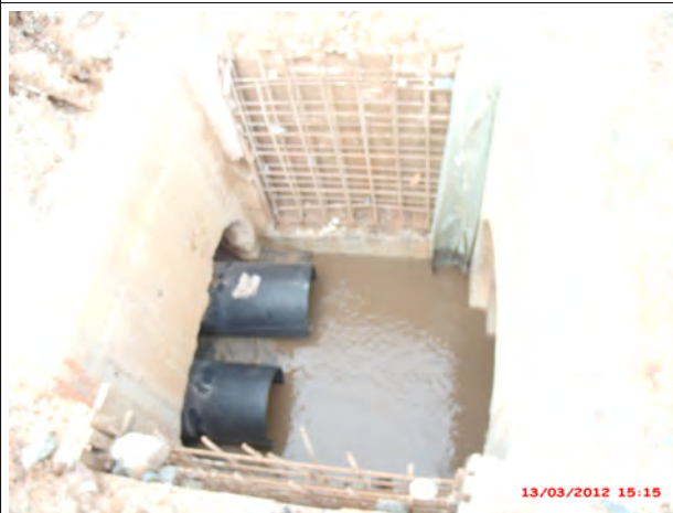
Foto 04 A: Caixa de direcionamento da água de drenagem do Pátio de Carvão. Conforme o nível da Bacia 71 (à esquerda) a parede central passa a funcionar como um ladrão.
