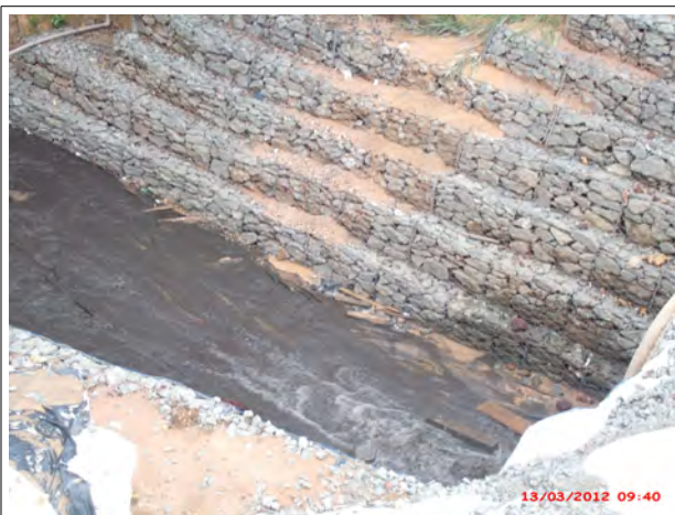
Foto 01 A: Drenagem do Pátio de Carvão sendo lançada no RIP RAP 2.
