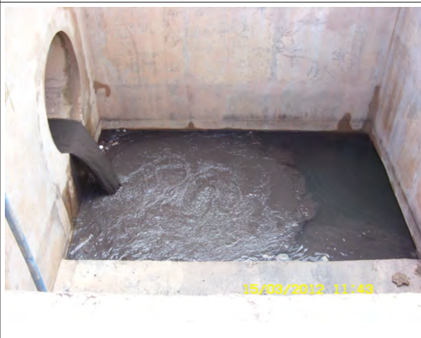
Foto 15 A: Liberação do Fluxo da drenagem do Pátio de Carvão para a Bacia 71, após bombeamento do efluente decantado.
