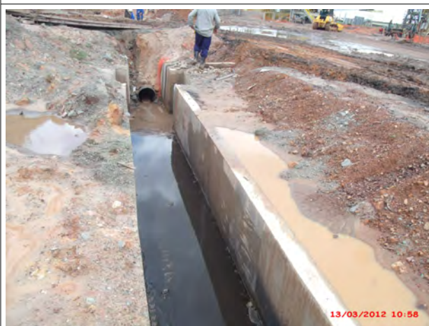
Foto 07 A: Integração das canaletas de drenagem dos Pátios de Carvão.
