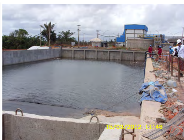
Foto 16 A: Transferência por caminhão pipa da drenagem do Pátio de Carvão para a Bacia 71, após bombeamento do efluente decantado.
