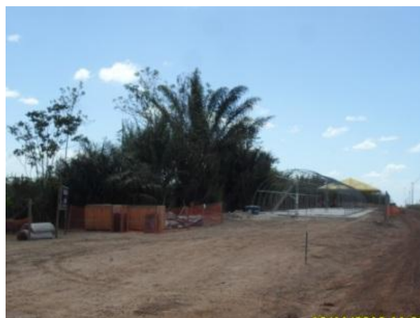
Foto 3-14: Visita a obra do viaduto do km72
