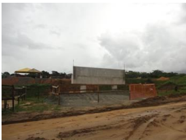
Foto 3-13: Visita a obra do viaduto do km08
