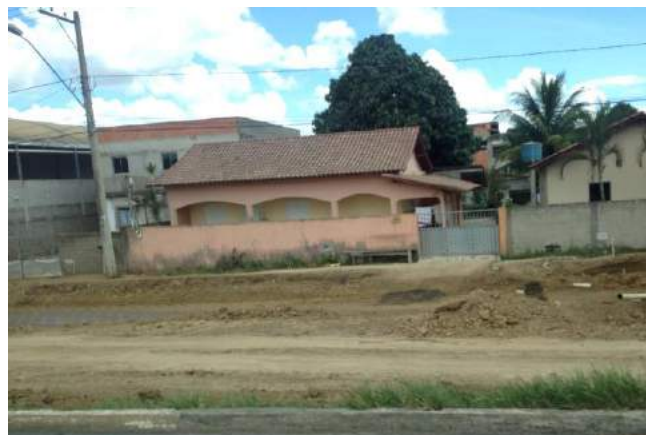
Foto 6.3.2-2 Tipo de Imóvel residencial às margens da BR-101
