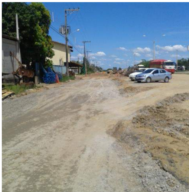
Foto 6.3.2-5 Obras para implantação de vias locais às margens da BR-101 no município de Sooretama (pista norte)
