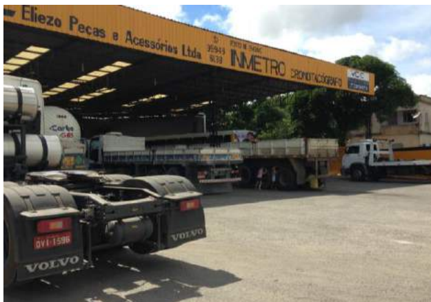
Foto 6.3.2-1 Tipo de Imóvel comercial, venda e prestação de serviços em Linhares
