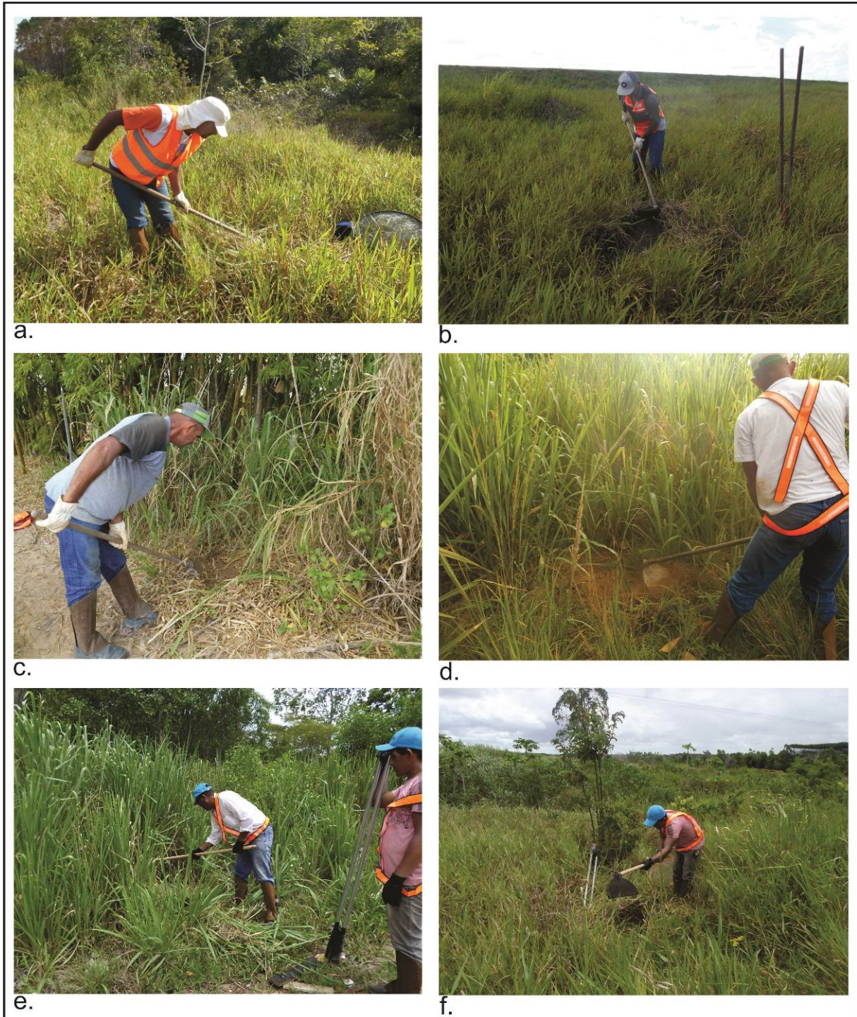
Fotos 1.5.1-6 Retirada da cobertura vegetal
