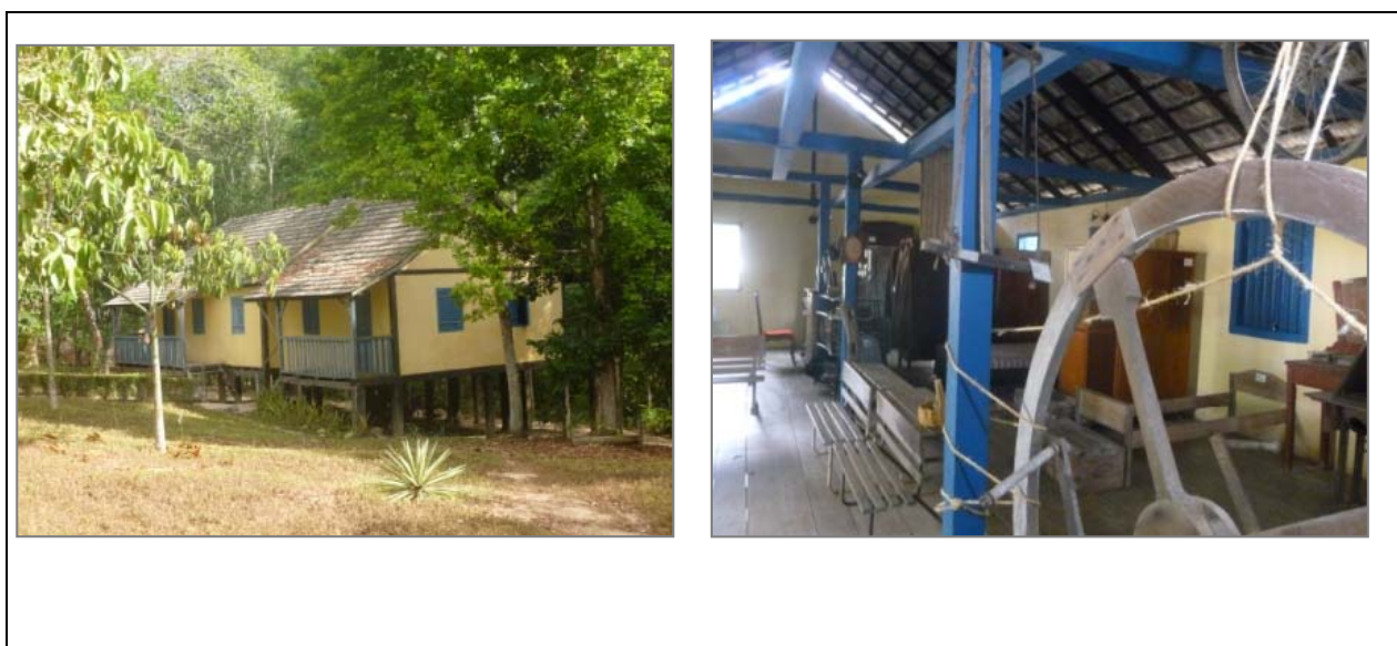
Fotos 2.1.3-71 Museu Histórico de Jaguaré: o imóvel expressa as técnicas construtivas dos primeiros colonizadores do município
