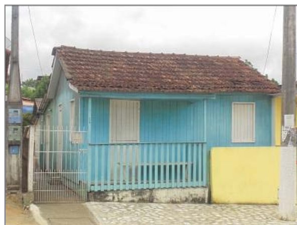
Foto 2.1.3-105 Exemplo de residência edificada em madeira, seguindo tradição dos imigrantes italianos em fins do século XIX. Distrito de Jacupemba, Aracruz - ES
