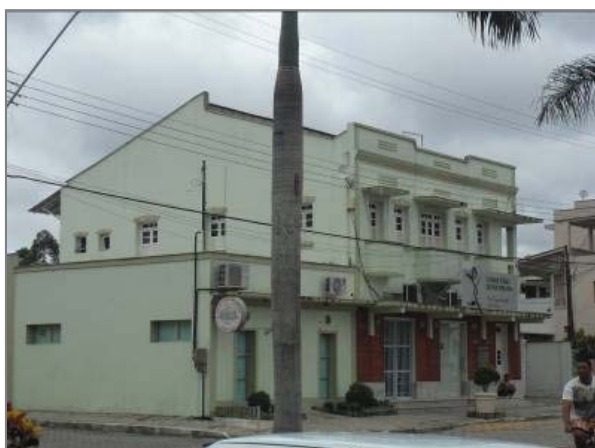
Foto 2.1.3-104 Sobrado construído entre as décadas de 1920 e 1940, já com muitas modificações em seu corpo e fachada. Distrito de Jacupemba, Aracruz -
