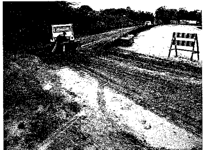
Desvio no Segmento não Pavimento Est.1531(Km 30,62), Provocando Atoleiro
