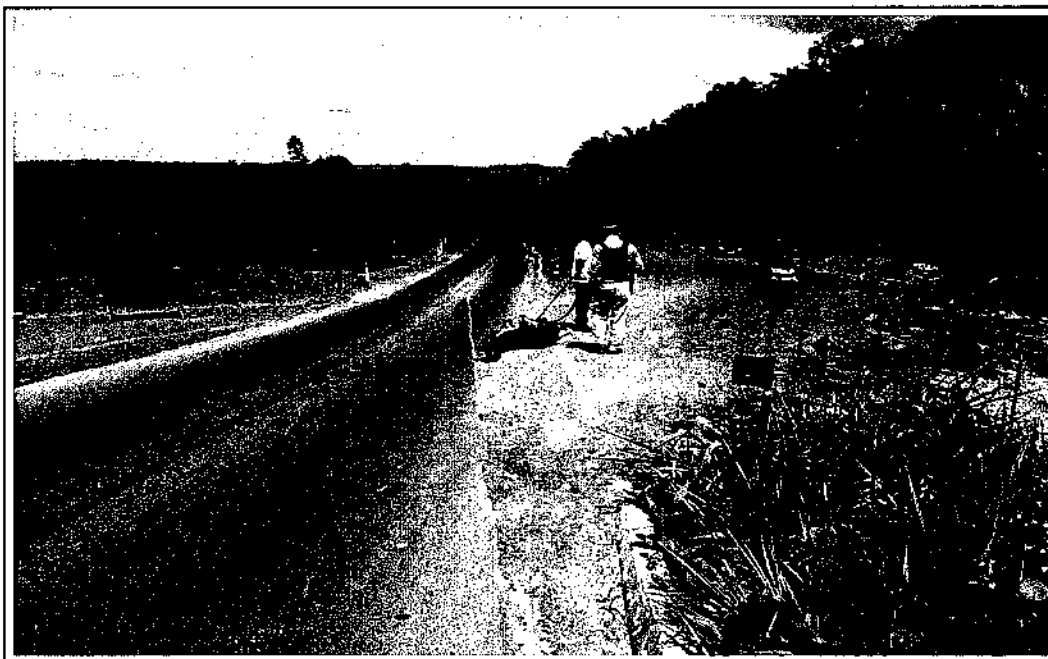
OBTENÇÃO DE IMAGENS COM RADAR ATERRO ESTACA 1902 A 1908
