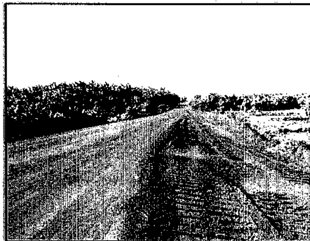
Foto 9 - Rodovia após supressão vegetal, estaca 4578. Lado direito. S 03. 98577° W 050. 26854° 31/05/2012
