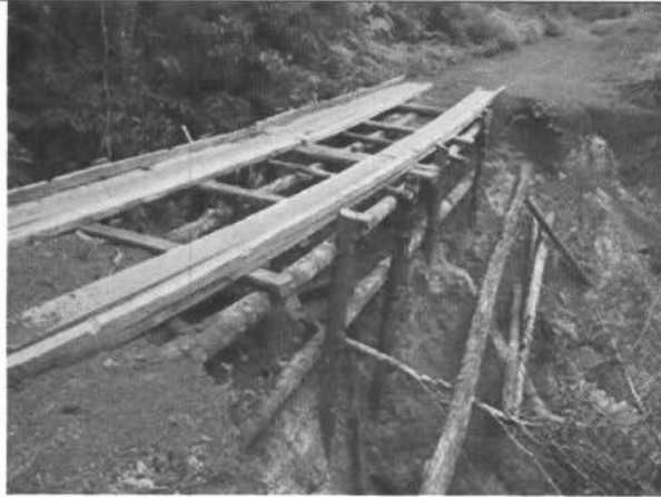
Ponte sobre o Igarapé Silva Filho
