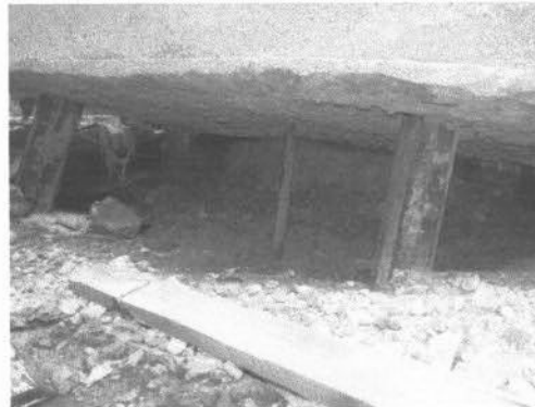
Blocos de ancoragem descalçados pela ação da correnteza, deixando as estacas a mostra
