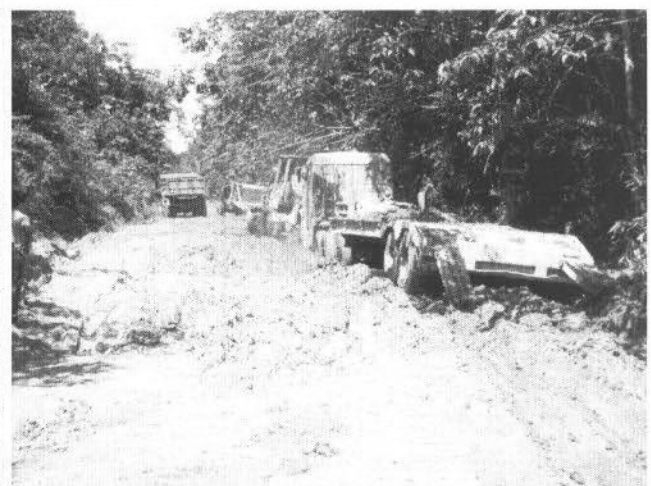
Figura 21: atoleiro com cerca de 50 metros de comprimento (Coordenadas UTM 19N 746796 / 22225)
