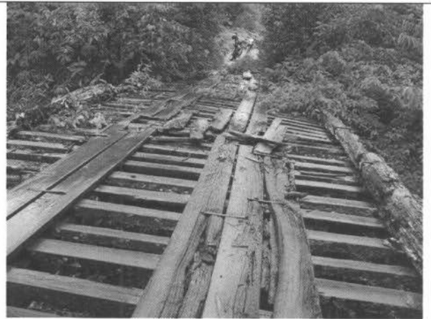
Ponte sobre o Igarapé Janine Jussara
