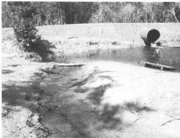
Figura 22: substituição proposta de bueiro por ponte de madeira (Coordenadas UTM 19N 743012 / 10363)
