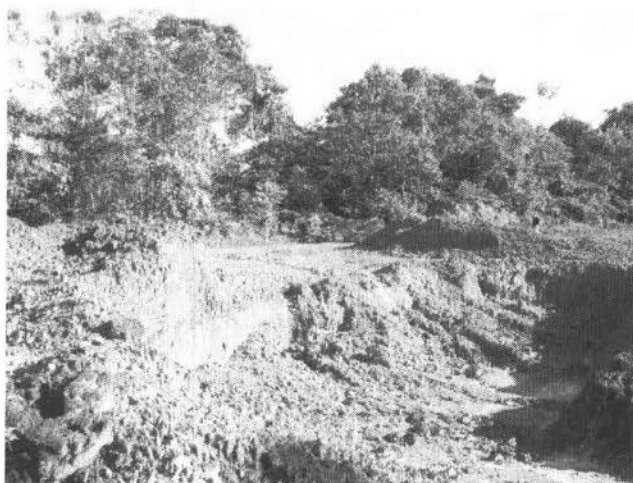
Figura 30: taludes erodidos e sem qualquer medida de recuperação
