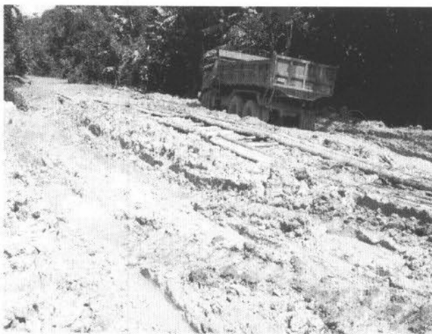
Figura 20: atoleiro com cerca de 150 metros de comprimento (Coordenadas UTM 19N 746747 / 21696)
