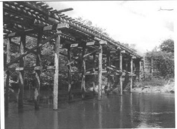
Ponte sobre Igarapé Já Mirim
