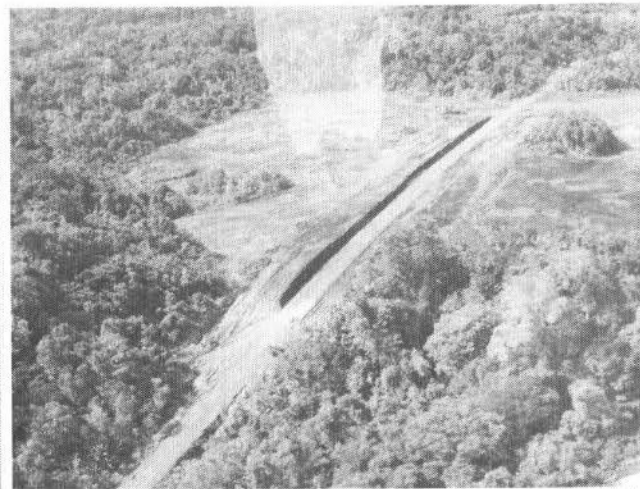
Figura 05: Jazida do Km 95 proposta pelo Exército para as obras, já utilizadas anteriormente e na presumida faixa de domínio da rodovia
