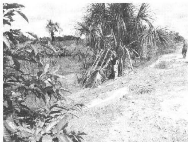
Figura 15: bueiro simples de concreto já implantado (Coordenadas UTM 19N 744829 / 16060)
