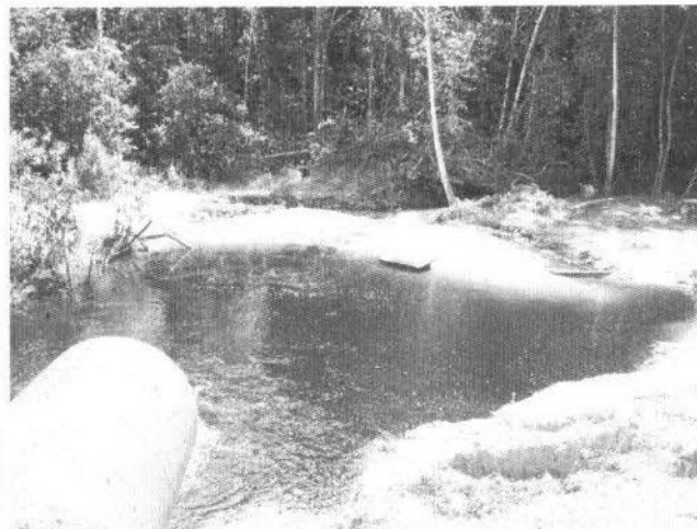
Figura 23: pequena ensecadeira com represamento parcial do igarapé – a ser retirado (Coordenadas UTM 19N 743012 / 10363)
