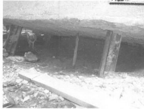
Blocos de ancoragem descalçados pela ação da correnteza, deixando as estacas a mostra
