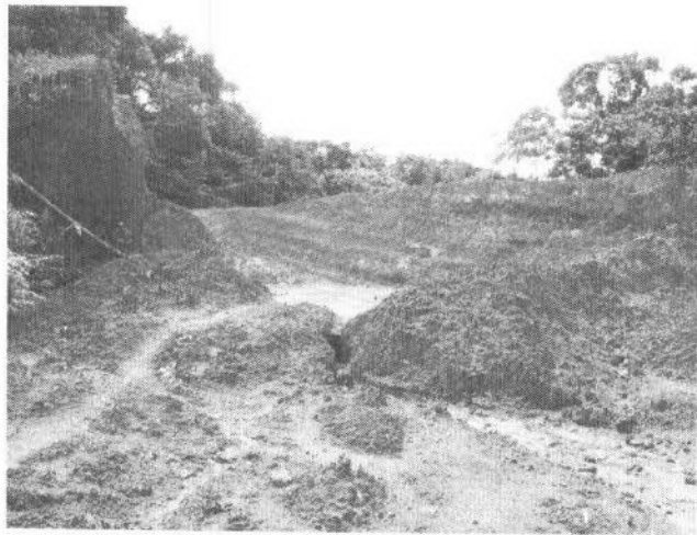
Figura 24: ausência de qualquer medida de controle da drenagem local
