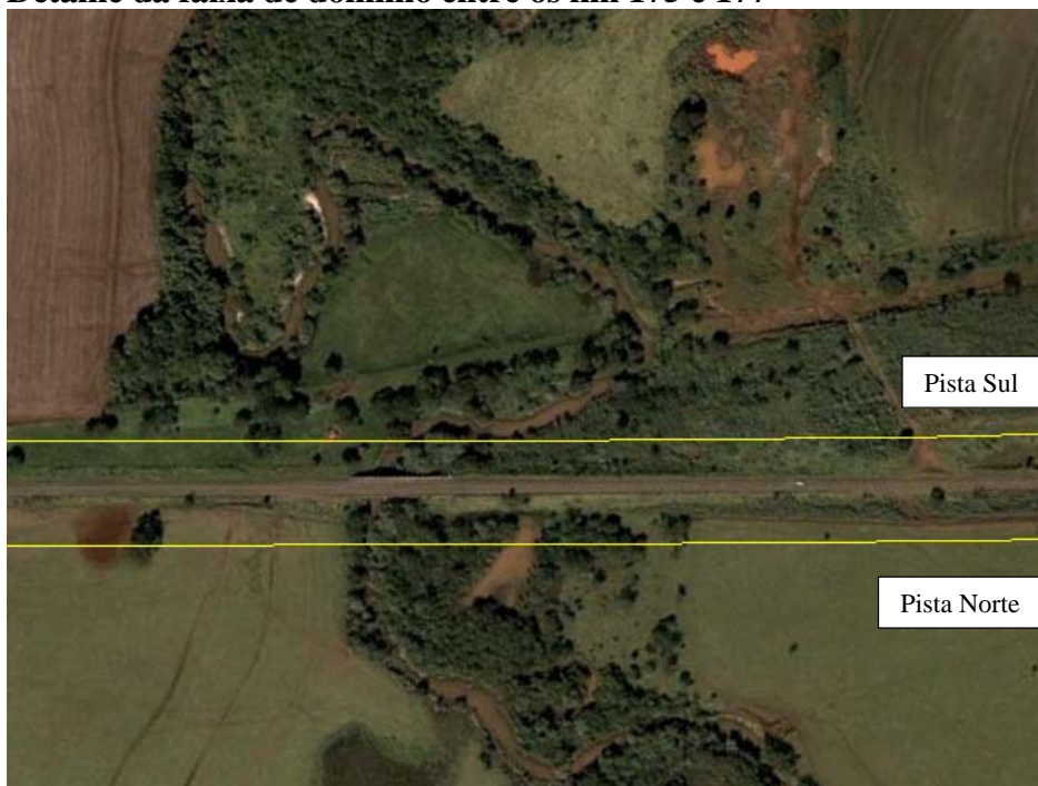
Figura 9.1.j Detalhe da faixa de domínio entre os km 175 e 177
