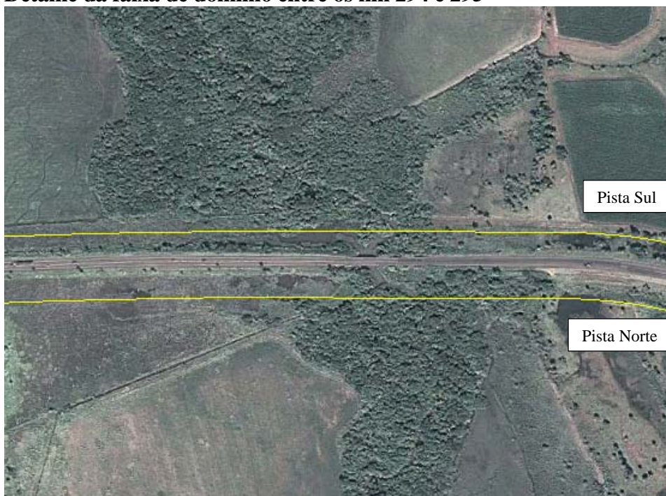
Figura 9.1.k Detalhe da faixa de domínio entre os km 294 e 295
