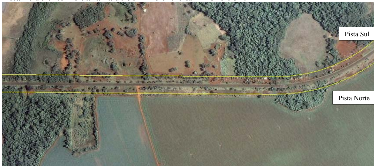
Figura 9.1.m Detalhe do entorno da faixa de domínio entre os km 318 e 320
