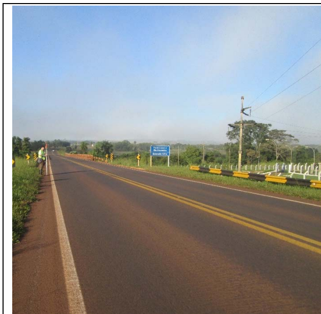
Rodovia BR-163, próximo ao km 241
