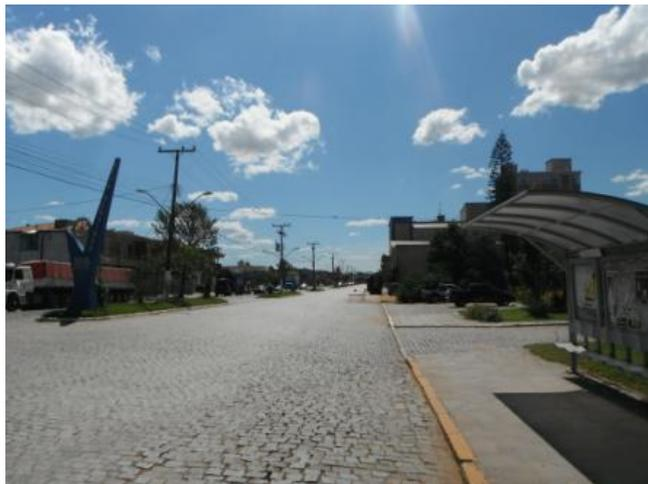
**Foto 17.** No início do traçado a Av. Loureiro da Silva apresenta pavimento de paralelepípedos com sensível deformação devido ao tráfego de veículos pesados.
