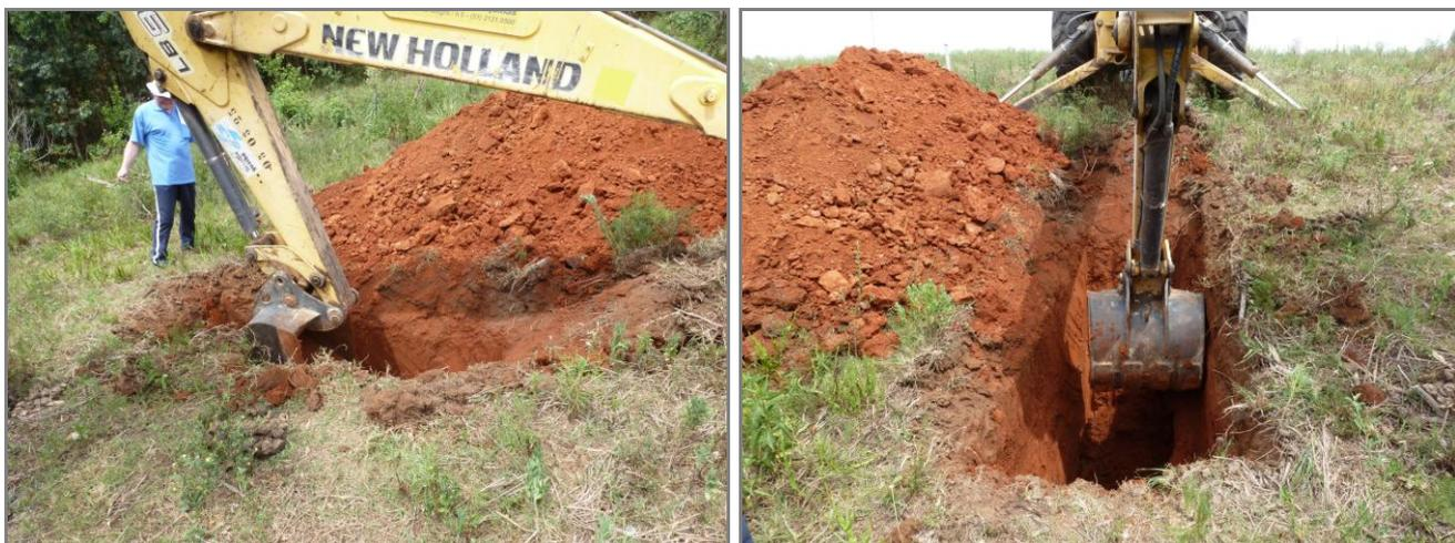
**Fotos 02 e 03.** Abertura da trincheira visando a exposição do perfil do solo no interior da área destinada ao Empréstimo Concentrado EC-02.
