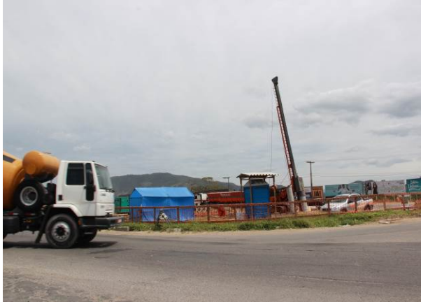
Pauta: construção do viaduto de acesso a Laguna/SC
