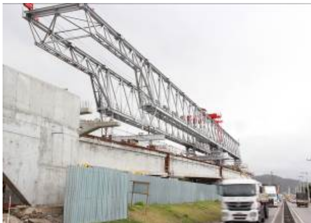
Pauta: operação da treliça-lançadeira na construção da Ponte de Laguna
