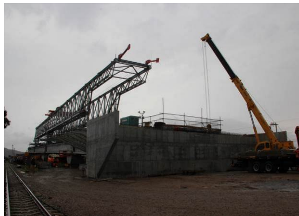
Pauta: operação da treliça-lançadeira na construção da Ponte de Laguna
