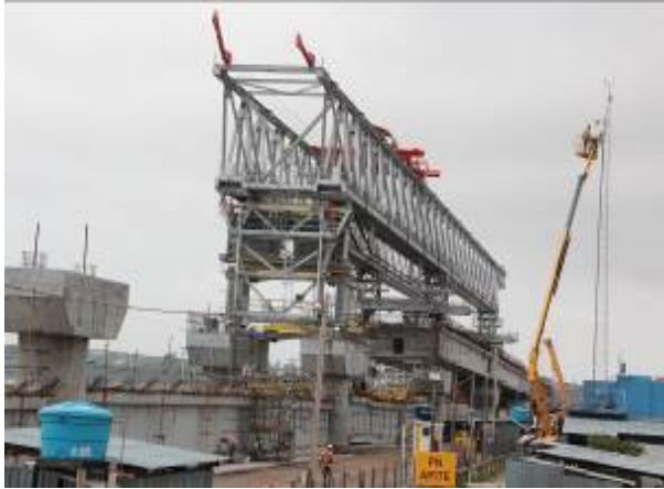
Pauta: operação da treliça-lançadeira na construção da Ponte de Laguna
