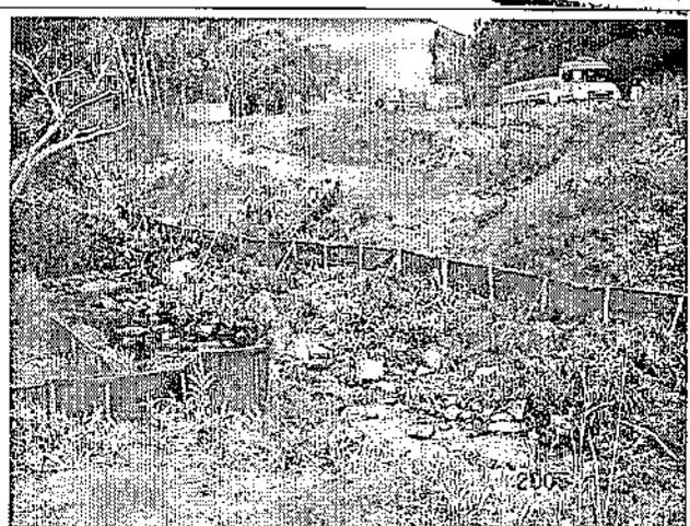
Foto 32 – Medidas de controle de erosão instaladas nas margens do rio Cova Triste após solicitação.
