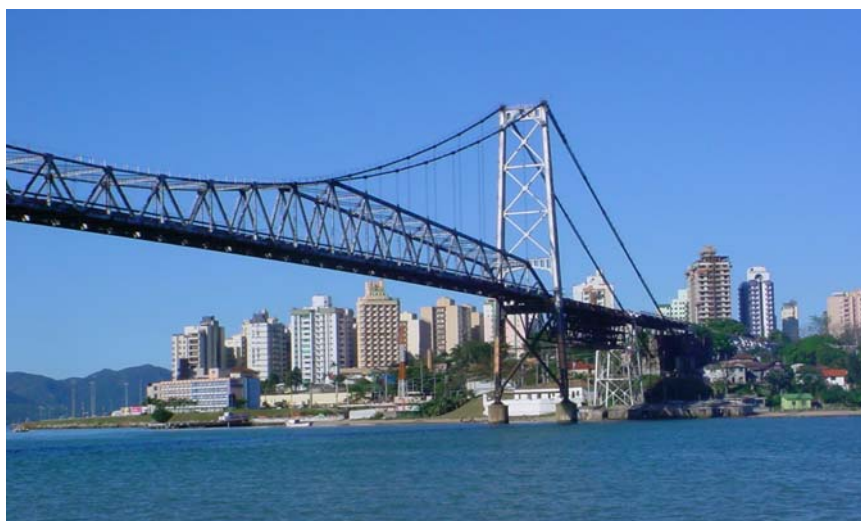
Figura II.4.2.3.A- 5 – Ponte Hercílio Luz, Florianópolis, SC.
