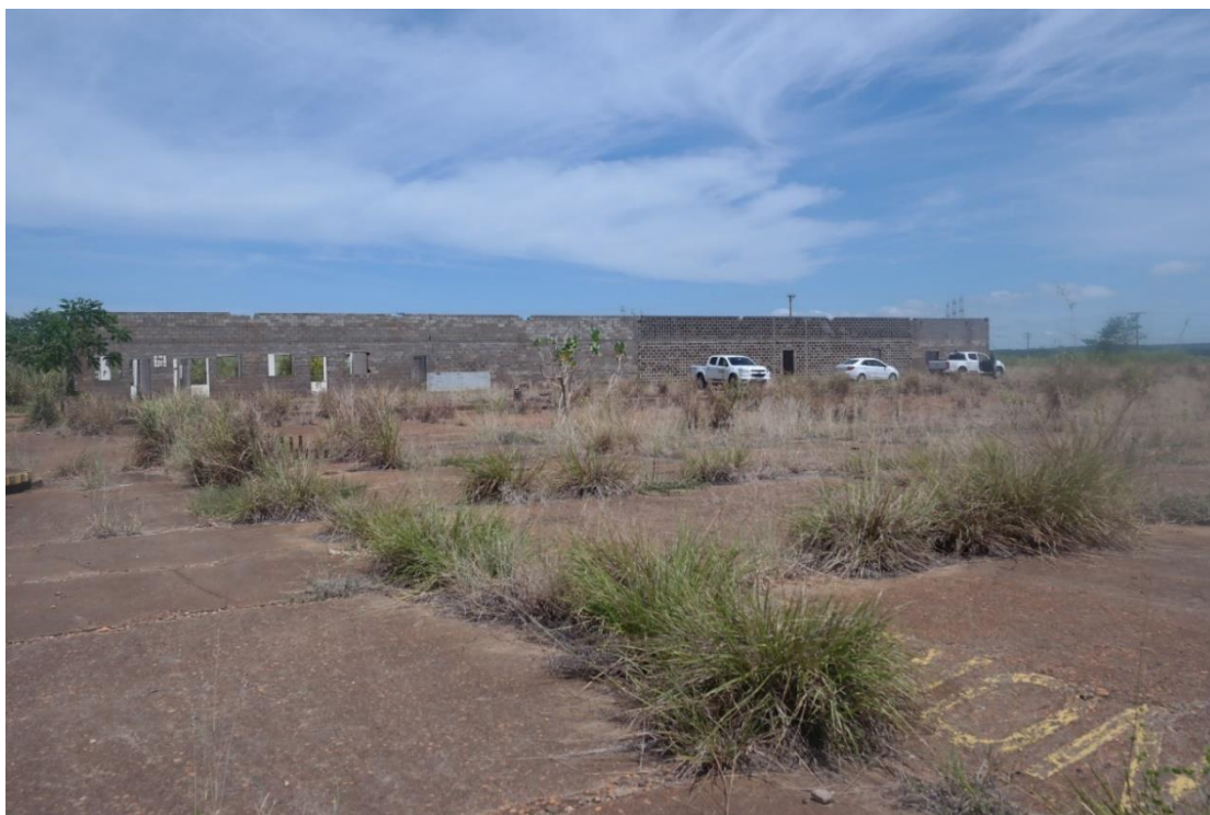
Figura 3.6-2 - Registro fotográfico de pátio e obras civis
