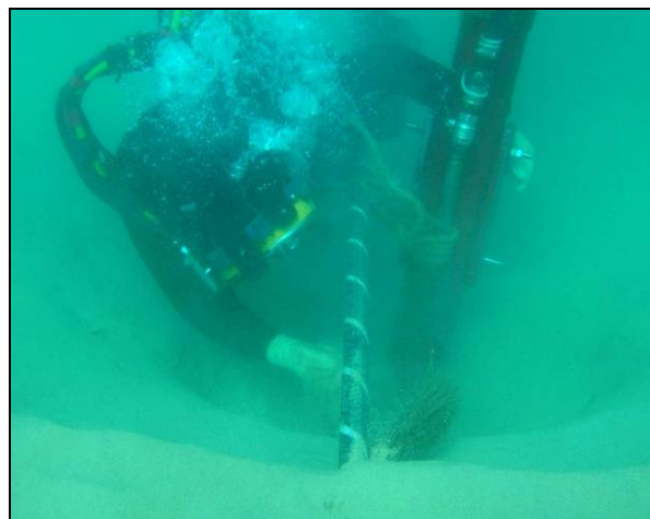
Figura III-11 - Ferramenta de jateamento manual - Airlifting
