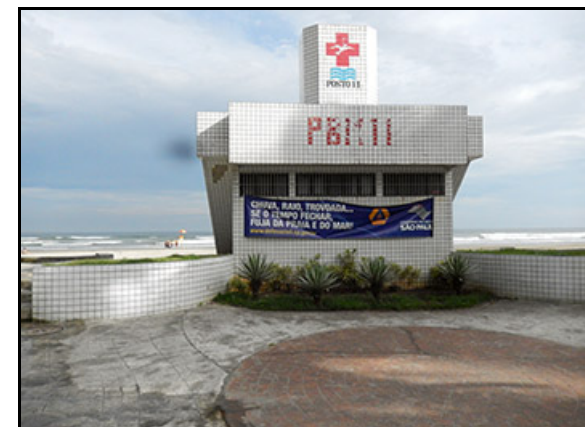
Figura V.3-8 - Posto de salva-vidas localizado na Praia Vila Caiçara, em Praia Grande- SP, próximo à área prevista para a instalação do cabo.
