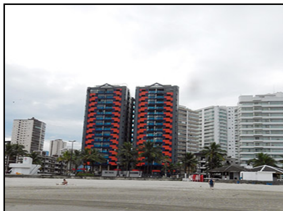
Figura V.3-7 - Vista para o calçadão desde a área de chegada do cabo óptico
