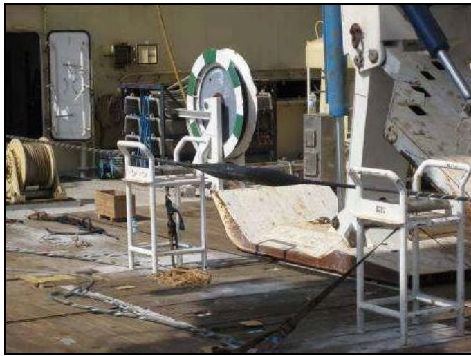
Figura III-3 - Exemplo de junção do cabo submarino, realizada a bordo do navio de instalação
