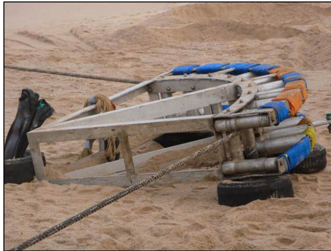
Figura III-13 - Exemplo de quadrante na praia - usado para executar o tracionamento do cabo ao longo da praia.
