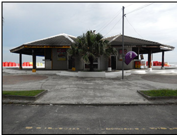
Figura V.3-5 - Vista de quiosques localizados próximos ao ponto de chegada do cabo óptico, no Bairro Vila Caiçara.
