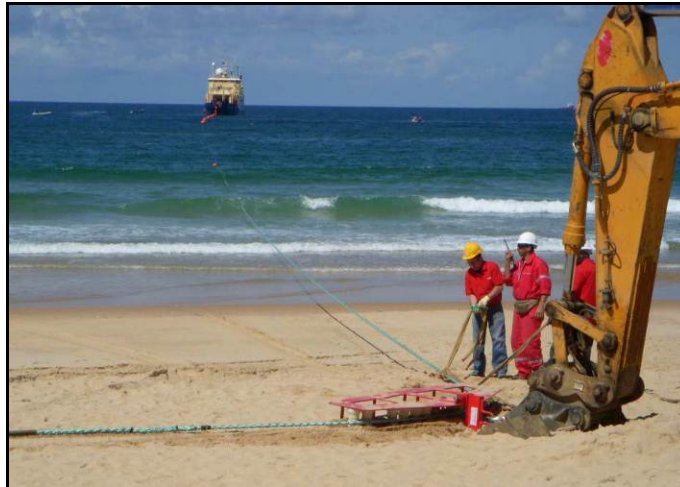
Figura III-21 - Uso do quadrante para a tracionamento do cabo submarino na faixa de areia
