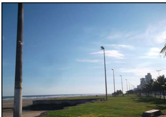
Figura V.2.1.1-5 - Orla urbanizada no ponto de chegada do cabo, município de Praia Grande - SP.
