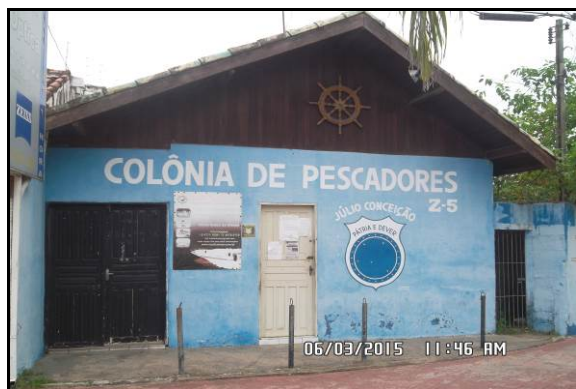
Figura V.3-22 - Foto com vista para o prédio da sede da Colônia Z-5 de Pescadores em Peruíbe
