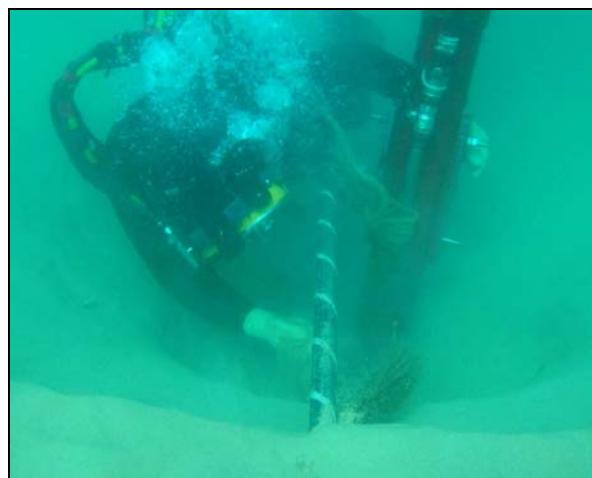
Figura III-11 - Ferramenta de jateamento manual - Airlifting
