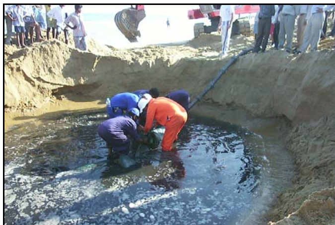
Figura III-19 - Obras de instalação do Sistema de aterramento
