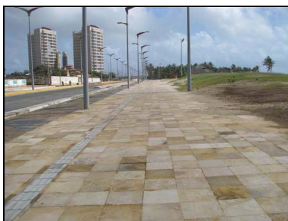
Figura V.2.1.1-1 - Orla urbanizada no ponto de chegada do cabo, município de Fortaleza - CE.
