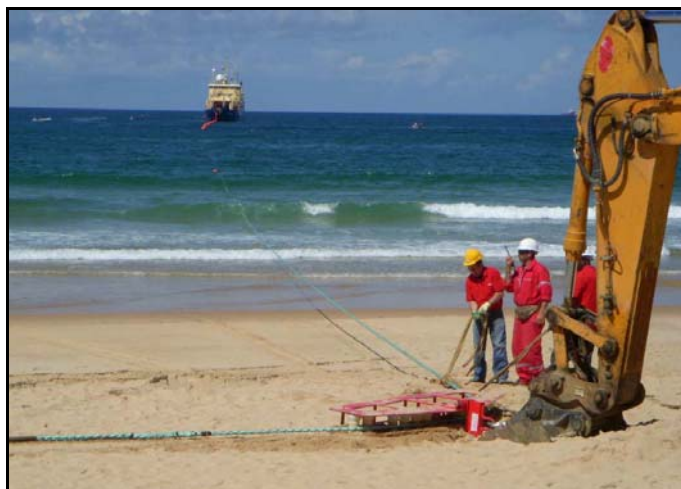
Figura III-18 - Uso do quadrante para a tracionamento do cabo submarino na faixa de areia
