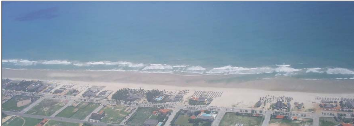
Figura V.1.4-1 - Fotografia da Praia do Futuro onde se nota bancos arenosos na zona de espraiamento, na porção da praia onde será instalado o Cabo ótico MONET.
