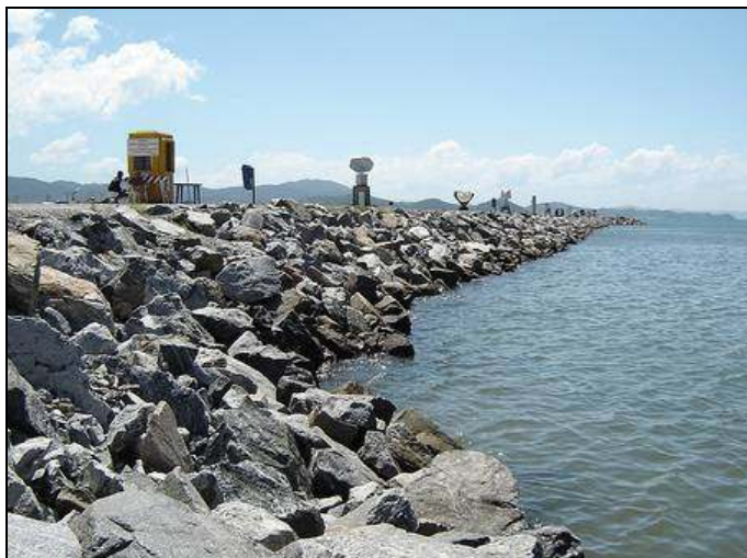
Figura 28. Exemplo de molhe construído com blocos de rochas.
