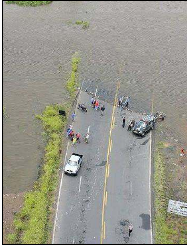
Figura 114. BR-101, próxima ao Município de Araranguá, submersa pela inundação ocorrida em novembro de 2008 ( http://www.clicrbs.com.br ).
