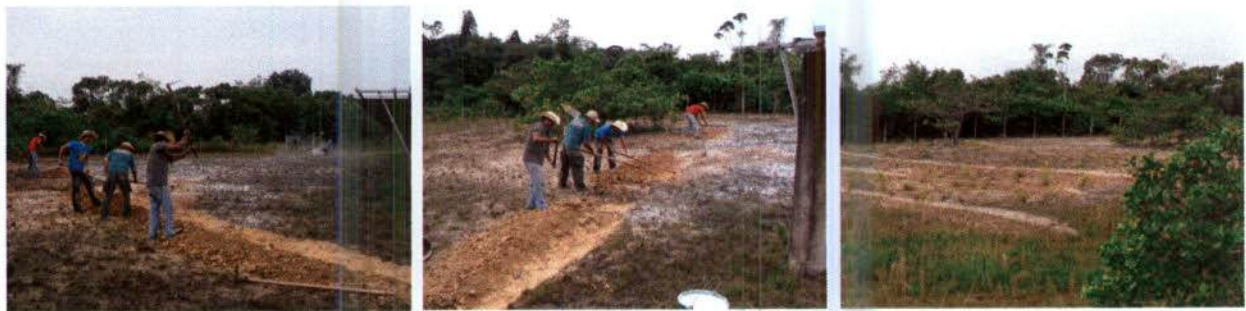
Imagem 3: Execução manual das curvas de níveis
