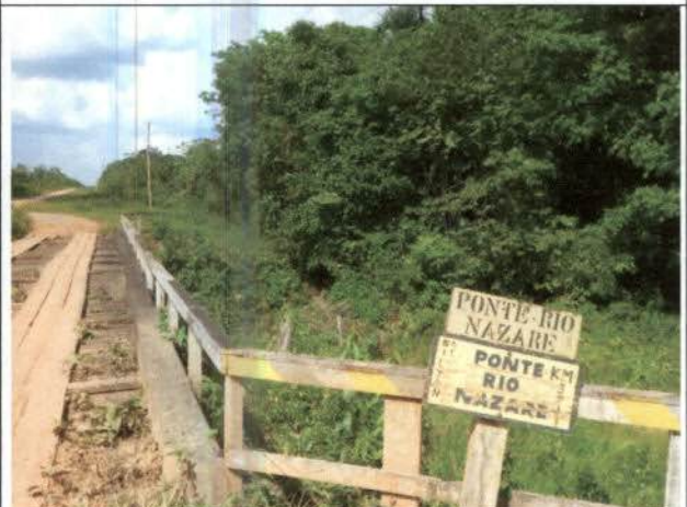
Foto 12 – APP do rio Nazaré que será interceptada pela rede (Trechos 3/4).
