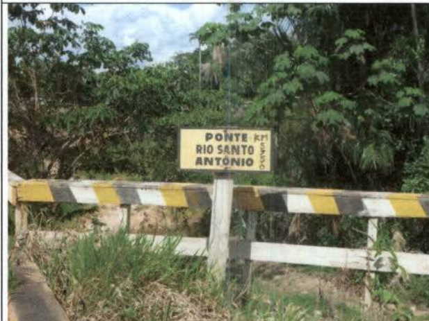
Foto 11 – APP do rio Santo Antônio que será interceptada pela rede (Trechos 3/4).
