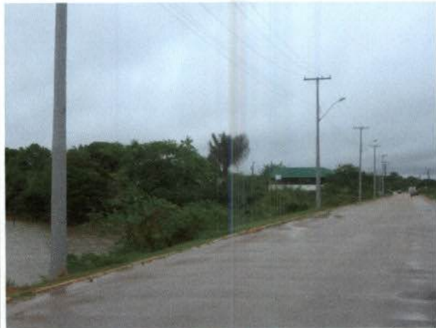
Foto 17 – Posteamto da empresa Amazonas Energia, que receberá a rede principal da EMBRATEL.
