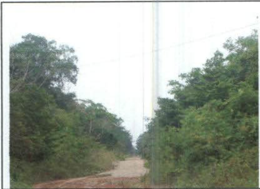
Cabo de fibra óptica em ZIG ZAG
