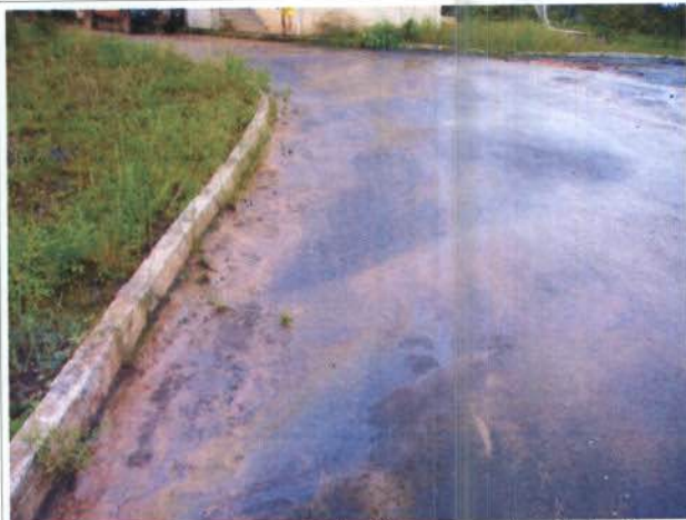
Foto 12 – Derramamento de óleo correndo - Estação Aristóteles.
