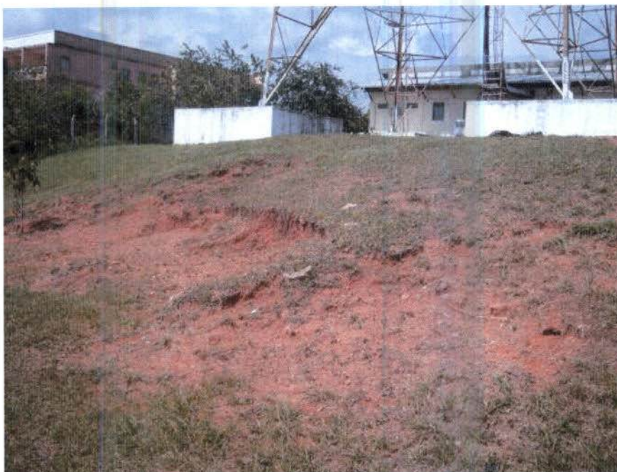
Figura 09: Estações Repetidoras no estado do Amazonas evidenciando declividade do terreno.
