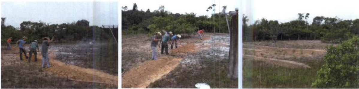
Conjunto de Fotos nº 2: Execução manual das curvas de níveis
