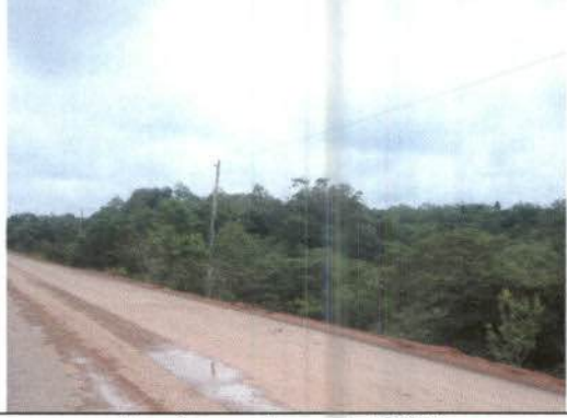
Trecho em obra pelo DNIT
