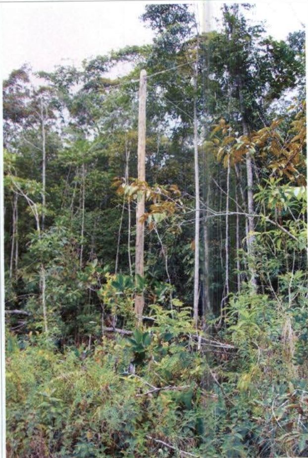
Foto 07 - Desbaste de vegetação secundária e cabo óptico com amarra eventual mais segura.
