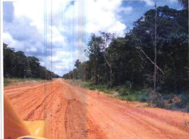
Foto 15 - Cabo óptico margeando rodovia.
