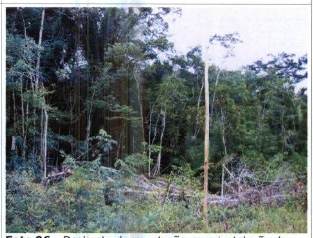
Foto 06 - Desbaste de vegetação para instalação do poste.
