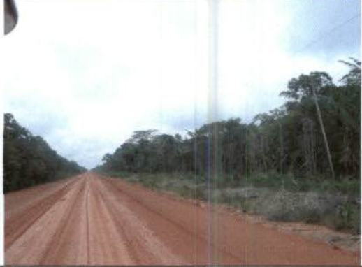
Trecho em obra
