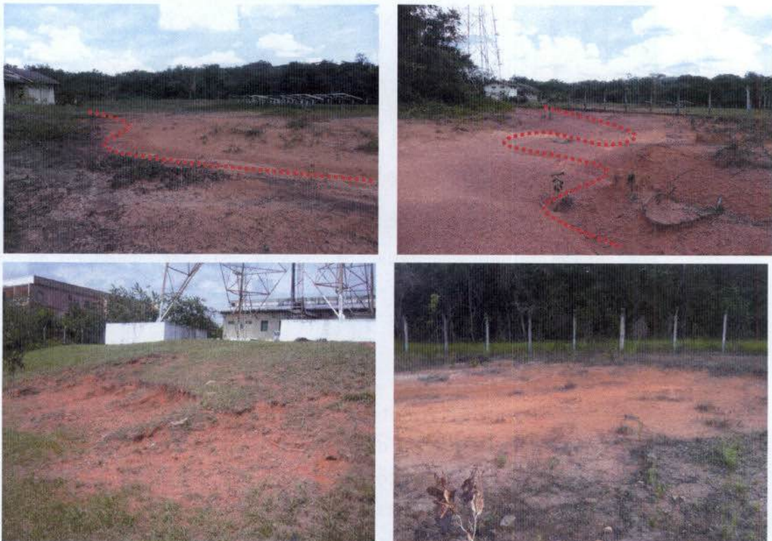
Conjunto de Fotos nº 1: Áreas com processos erosivos
