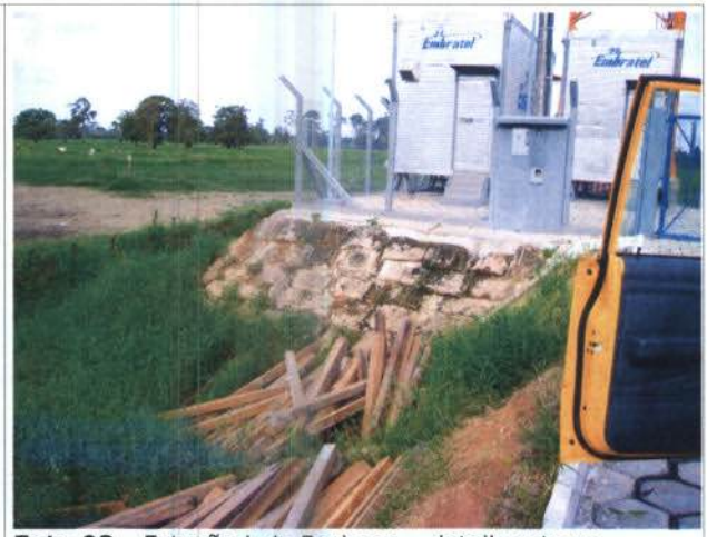
Foto 02 - Estação Luiz Barbosa - detalhe aterro.
