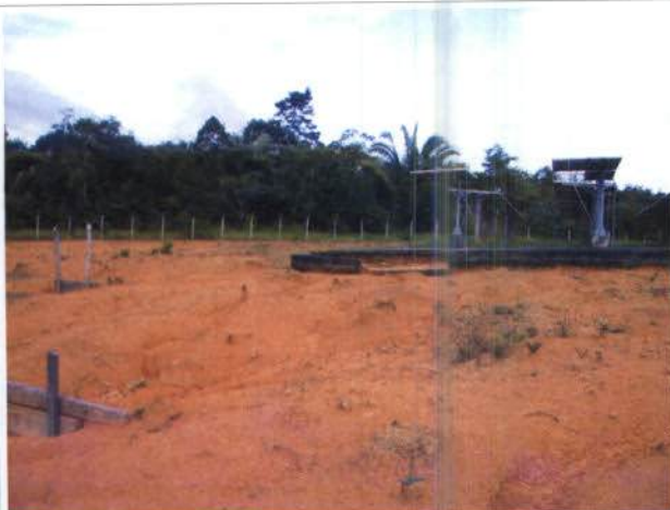
Foto 10 - Erosão na área da Estação Aristóteles.
