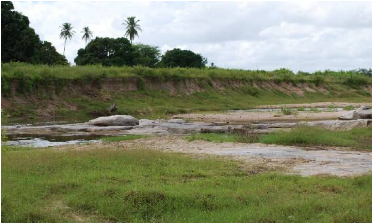
Fotografia 8 - Processos erosivos na planície do rio Bujari.
