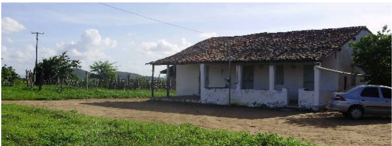
Fotografia 69 - Vista de uma das residências da comunidade.
