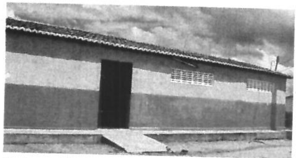
Fotografia 65 - Escola municipal da comunidade.
