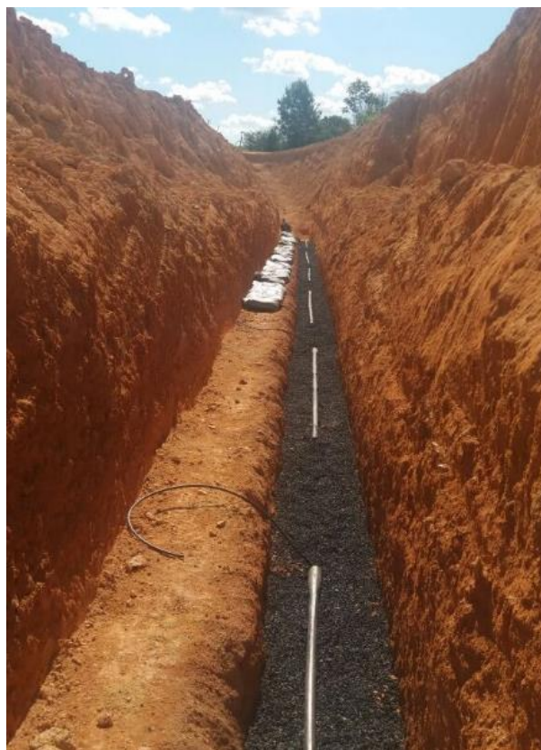
Figura 9.7 - Lançamento de Anodos no interior das valas.
