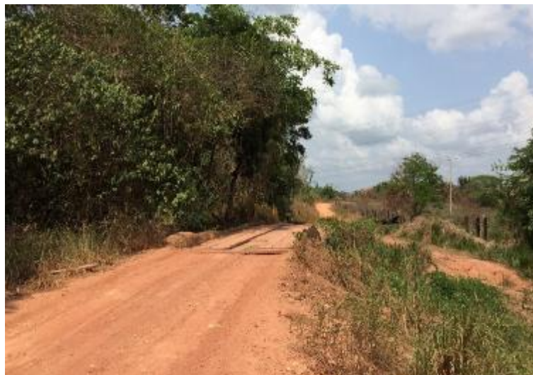
Figura 3.7 – Ponte estreita de madeira na estrada de terra.
