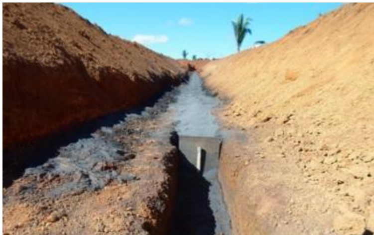
Figura 4.5 - Imagem ilustrativa de uma vala aberta de um Eletrodo.
