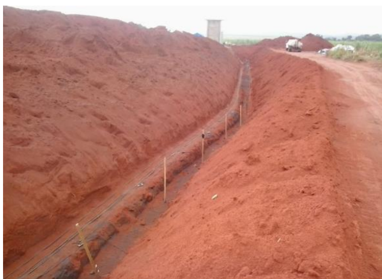
Figura 9.8 - Lançamento de cabos
