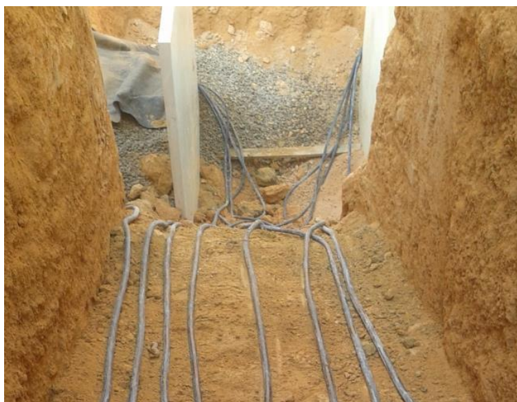
Figura 9.9 - Lançamento de Cabos de Interligação no interior de valas
