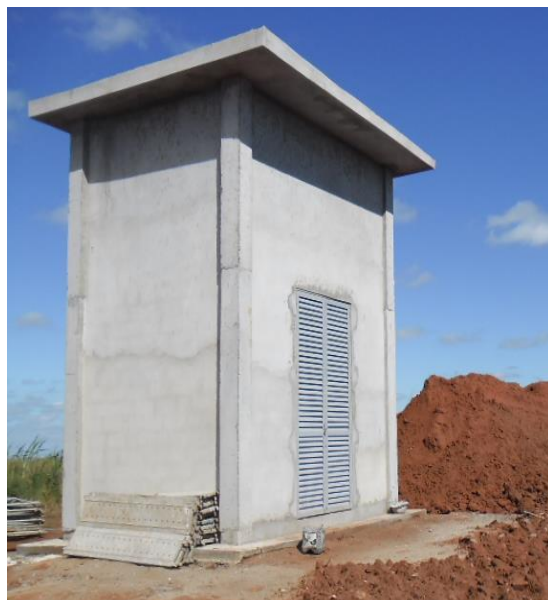
Figura 9.16 - Casa de chaveamento toda em concreto com porta de aço
