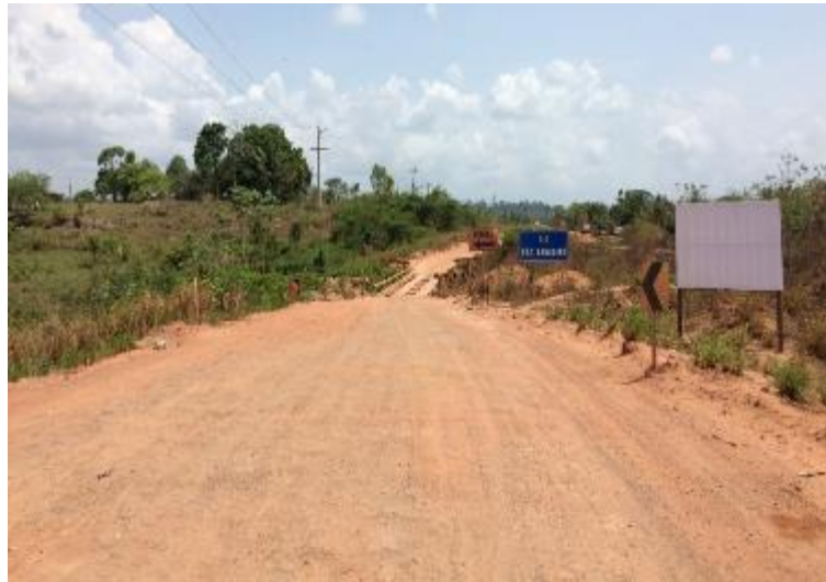
Figura 3.4 – Ponte estreita na rodovia Transamazônica BR-230, sentido Anapú.
