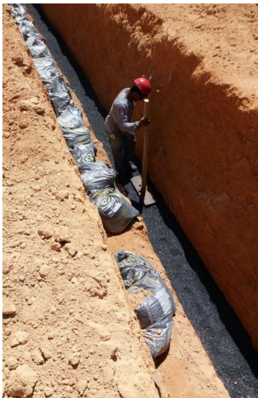
Figura 9.5 - Aplicação e compactação do coque
