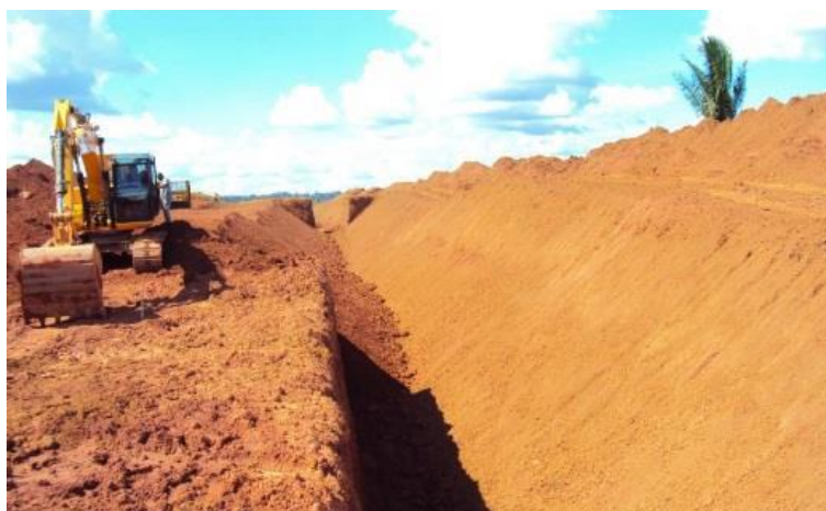
Figura 9.4 - Escavação (talude)
