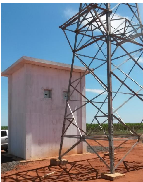
Figura 9.14 - Casa de chaveamento próxima a torre da LT (vista das janelas das buchas)
