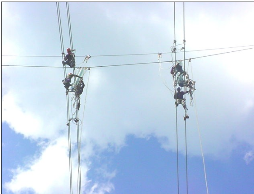
Figura 3.4.7.3.e Trabalhos de grampeamento
