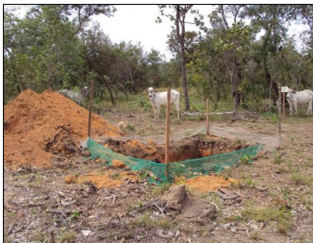
Figura 3.6.9.2.1-1 - Cercamento de cavas de fundações
