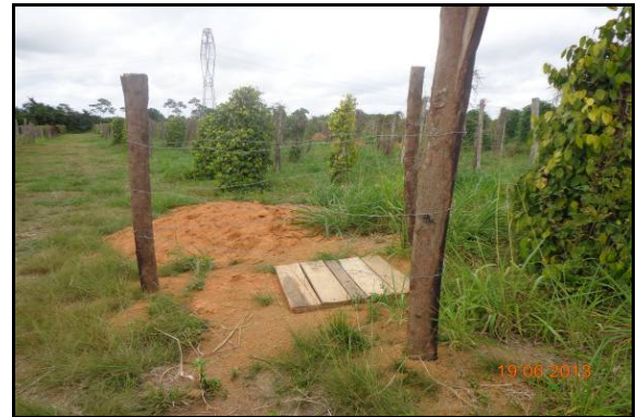
Figura 4.4-1 - Cercamento e cobertura de cavas de fundações
