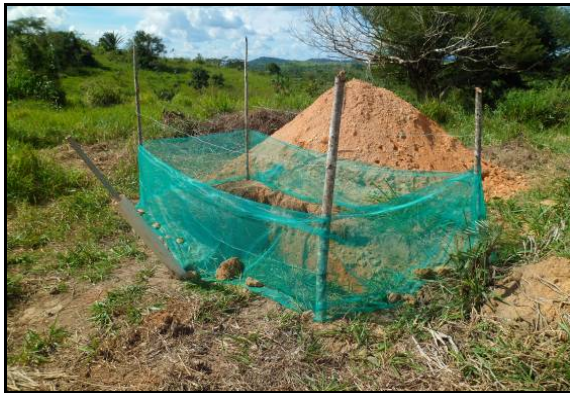
Figura 4.4-1 - Cercamento e cobertura de cavas de fundações
