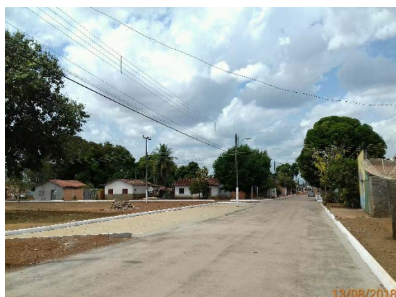
Figura 29. Via interna – sede de Caseara/TO
