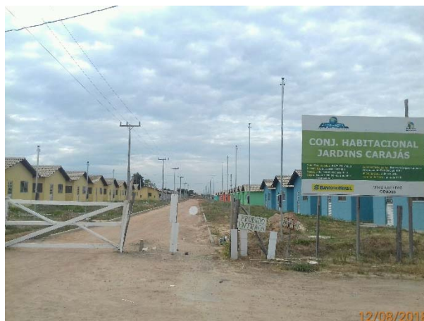
Figura 41. Conjunto Jardim Carajás em construção (Santana do Araguaia/PA) – Programa Minha Casa Minha Vida
