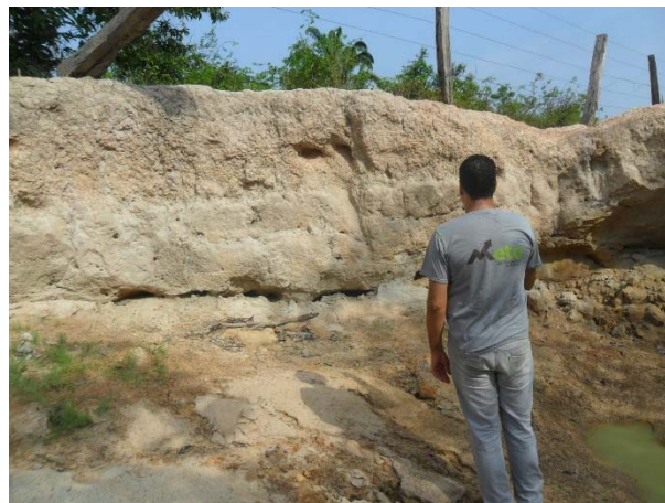
Figura 70: Vista parcial da bacia de retenção situada a jusante do sulco erosivo em drenagem efêmera (567745 E/ 8964744 N).
