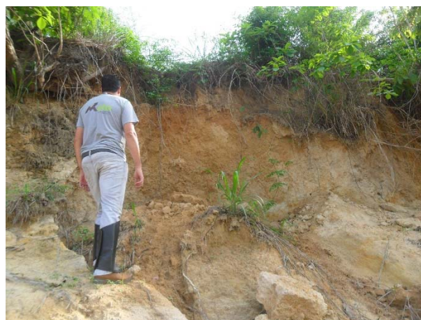
Figura 74: Detalhe do solapamento do solo a margem esquerda do Rio Campo Alegre instalado em solo arenoso (coordenadas UTM 568145 E/ 8964627 N).
