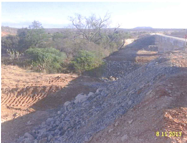
Figura 3 – Bacia de acumulação implantada no Km 1166+000
