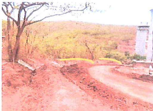
Construção canaletas e 02 bacias de infiltração e contenção (lado esquerdo) no viaduto Brejinho I. Data: 30/10/2013.
