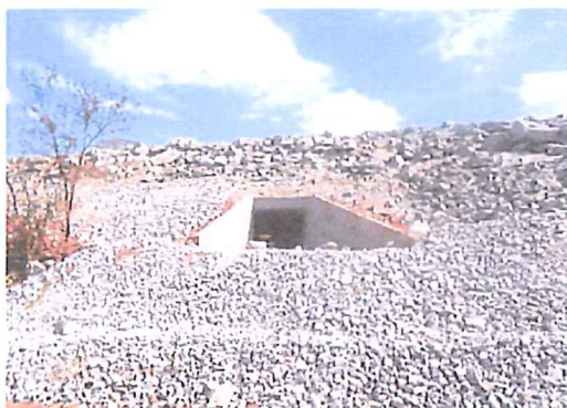
Enrocamento do corta-rio realizado no Km 991+360. Data: 29/10/2013.
