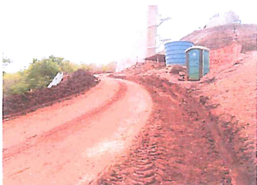
Construção canaletas que direcionam a água pluvial para as bacias de infiltração e contenção (lado esquerdo) no viaduto Brejinho I. Data: 30/10/2013.
