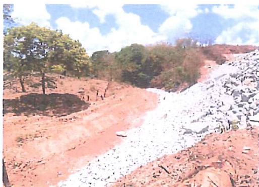
Enrocamento do corta-rio realizado no Km 991+360. Data: 12/11/2013.
