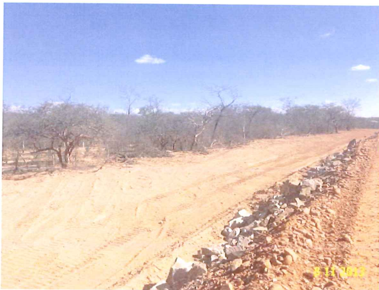
Figura 1 – Conformação de expurgo no km 1193+760
