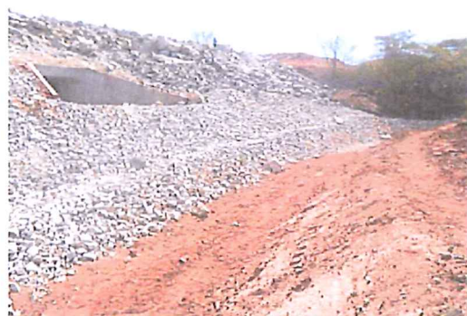
Enrocamento do corta-rio realizado no Km 991+360. Data: 29/10/2013.
