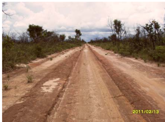
Figura 3.1-2e): vista da estrada que margeia o eixo: relevo plano e solo cimentado, ainda não recoberto por sedimentos recentes
