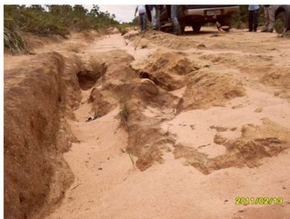
Figura 3.1-7: Sulco erosivo em estrada de acesso ao eixo, identificado ao lado do eixo, no Km 542+240.
