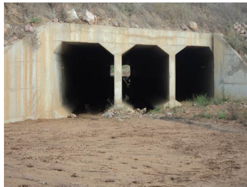
Foto 3-30 Bueiros em construção ao longo de todos os lotes.
