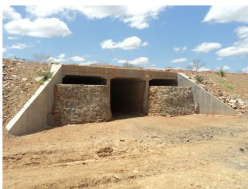
Foto 2-21 – Bueiro triplo com duas unidades de vazão obstruída formando ponto de armazenamento e captação de água, estaca 62146.
