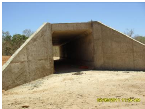
Foto 2-1 Bueiro simples construído no lote 1.
