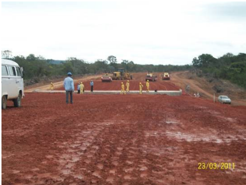
Foto 3-11 Procedimento de terraplanagem em vários locais nos lotes.
