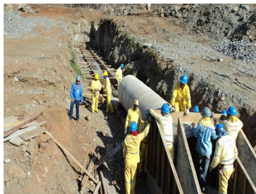
Foto 2-32 – Bueiro em execução, estaca 71163.
