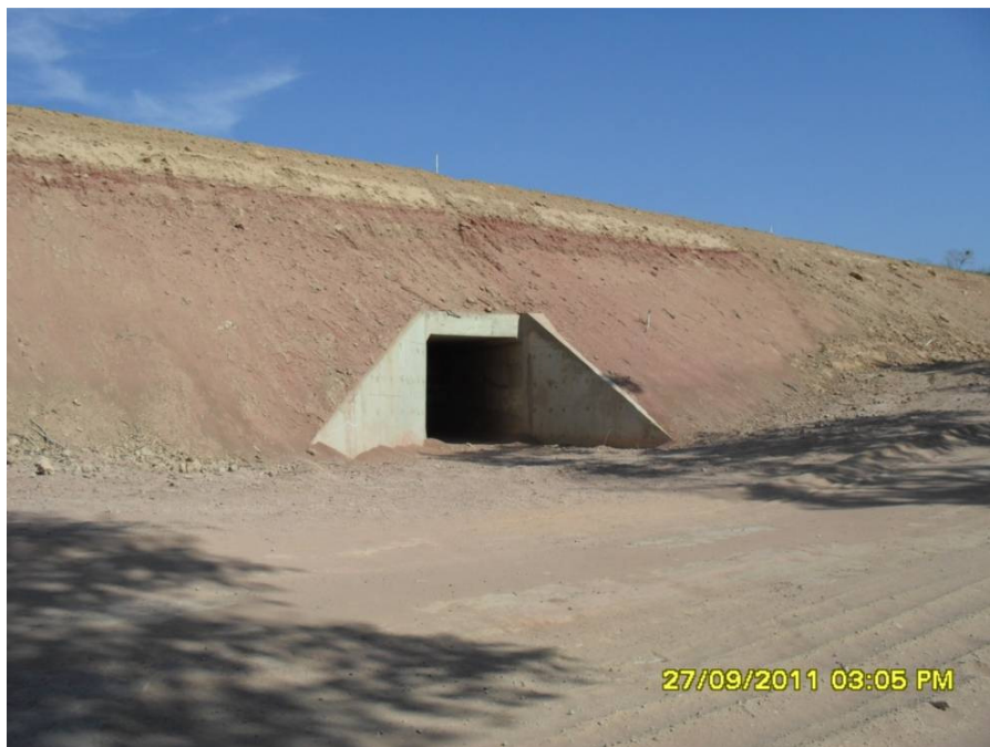
Foto 2-5 Bueiro simples com camada de aterro concluída, Lote 1.
