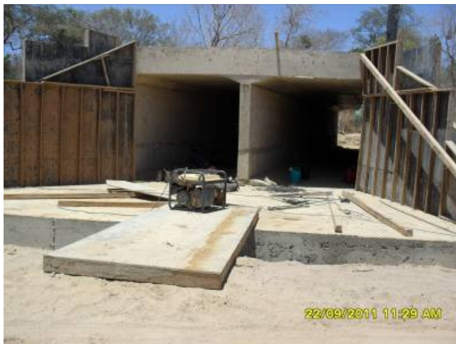
Foto 2-8 Construção das alas para finalização do bueiro duplo 2,00 x 2,00.
