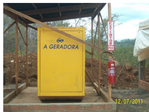
Foto 3-54 Unidades geradores acondicionadas sobre superfície impermeável para conter vazamentos.
