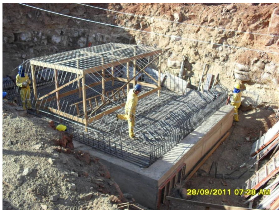
Foto 2-13 P9 sapata do pilar 9 em construção.
