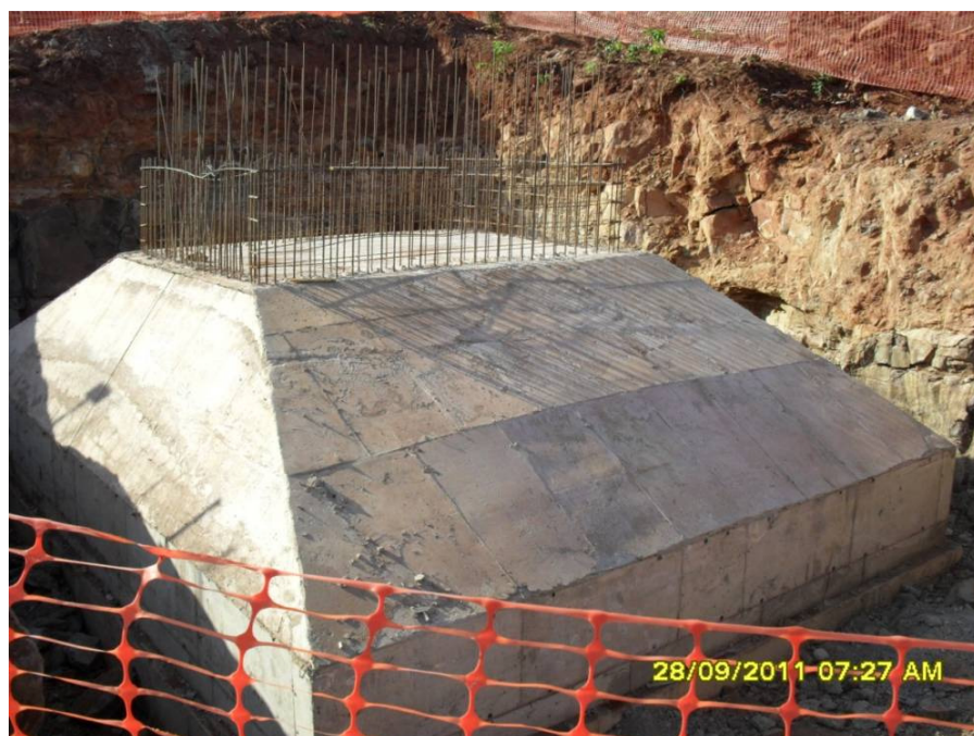
Foto 2-14 P8 sapata do pilar 8 concluída.
