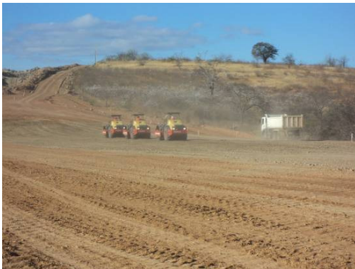
Foto 3-13 Rolos compactador sobre o aterro do traçado da ferrovia.
