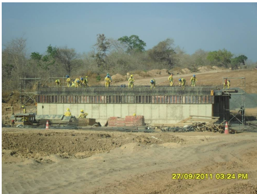
Foto 2-6 Bueiro Triplo 3,00 x 3,00 em construção.
