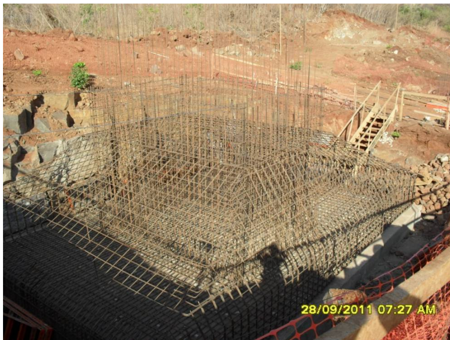
Foto 2-15 P7 sapata do pilar 7 em construção.
