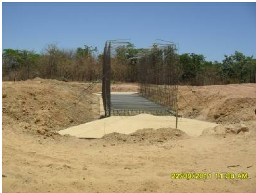
Foto 2-10 Construção de bueiro simples 3,00 x 3,00.
