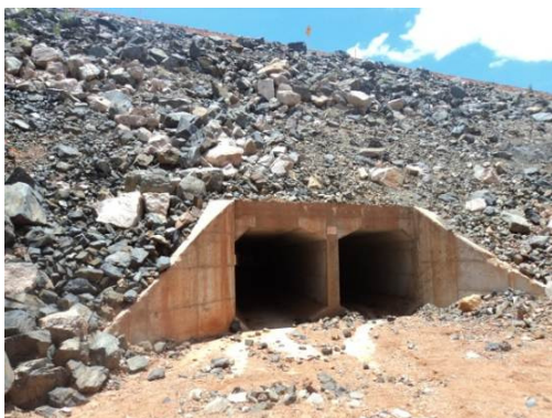
Foto 2-19 Bueiro duplo concluído e desobstruído, estaca 62466.
