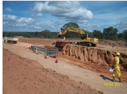
Foto 3-12 Escavações no eixo do traçado da ferrovia.
