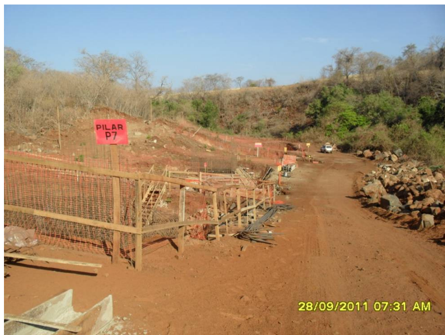
Foto 2-11 Construção das sapatas dos pilares da ponte, lote 2.
