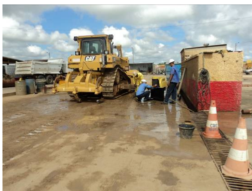
Foto 3-39 Lavadores de máquinas e equipamentos com piso impermeável e separador de água e óleo.
