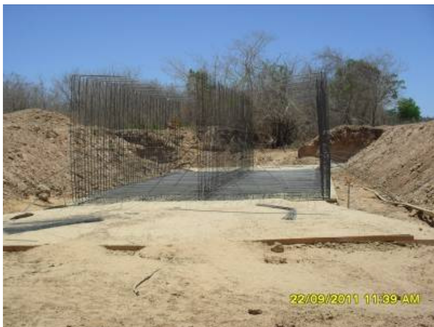
Foto 2-7 Início da construção de um bueiro duplo 3,00 x 3,00.
