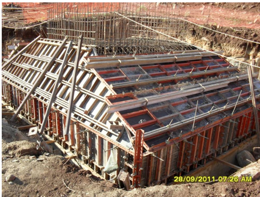
Foto 2-16 P6 sapata do pilar 6 em construção.
