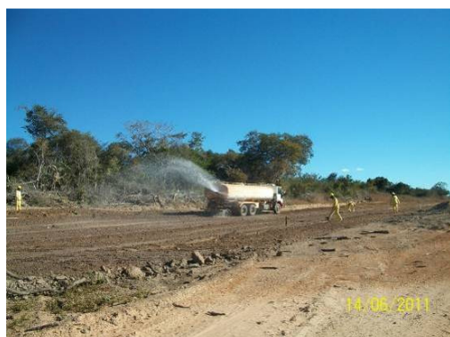
Foto 3-67 Umectação do traçado da ferrovia.
