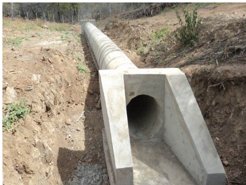
Foto 3-29 Alguns bueiros estão prontos aguardando a chegada da terraplanagem do traçado.
