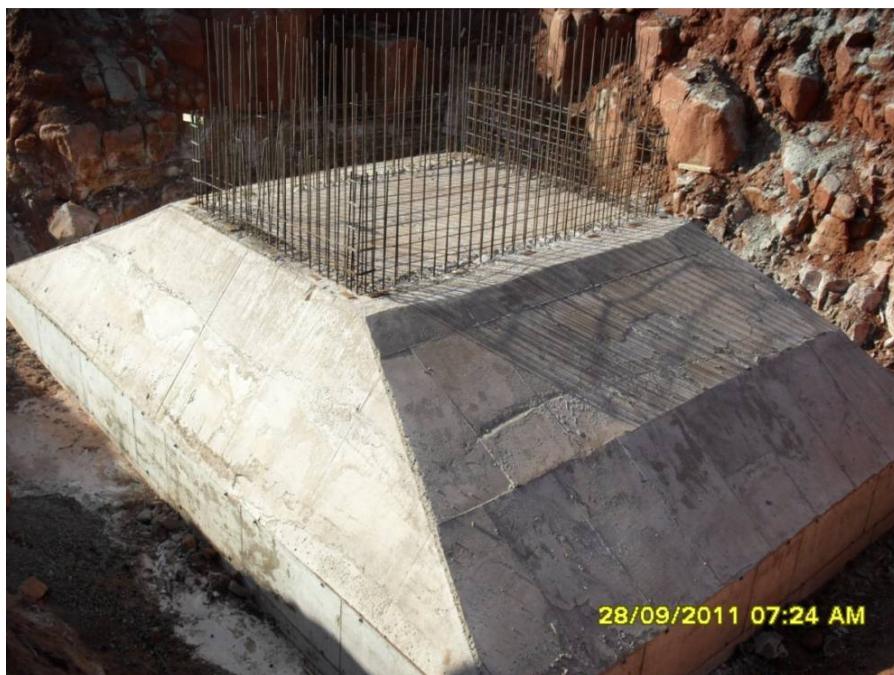
Foto 2-18 P4 sapata do pilar 4 concluída.
