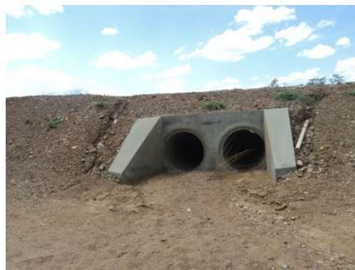
Foto 2-20 Bueiro duplo concluído e desobstruído, estaca 62071.
