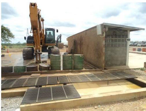
Foto 3-41 Separador de água e óleo.
