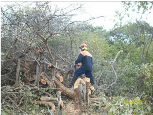
Foto 3-7 Operador de motosserra desdobrando material para enleiramento.
