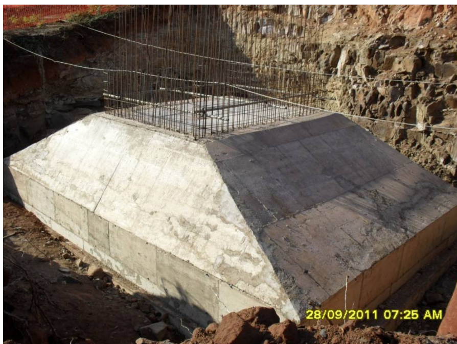
Foto 2-17 P5 sapata do pilar 5 concluída.
