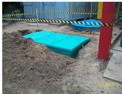
Foto 3-58 Caixa separadora de água e óleo em instalação.
