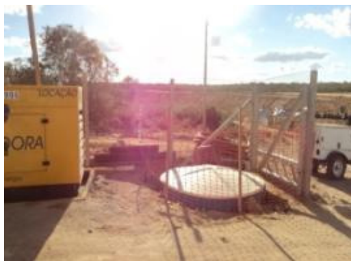
Foto 3-57 Fossa séptica instalada para atender a demanda de efluentes.
