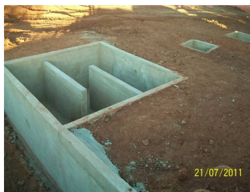
Foto 3-78 Sistema separador de água e óleo em construção.
