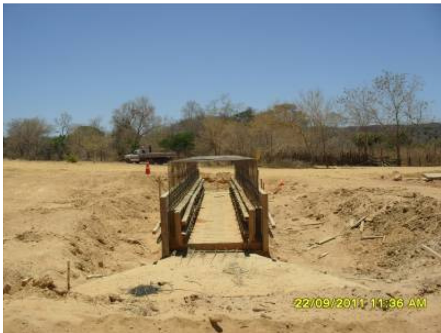
Foto 2-9 Construção de bueiro simples 1,5 x 1,5.
