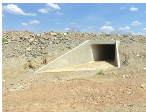
Foto 2-22 Bueiro concluído e desobstruído, estaca 62020.
