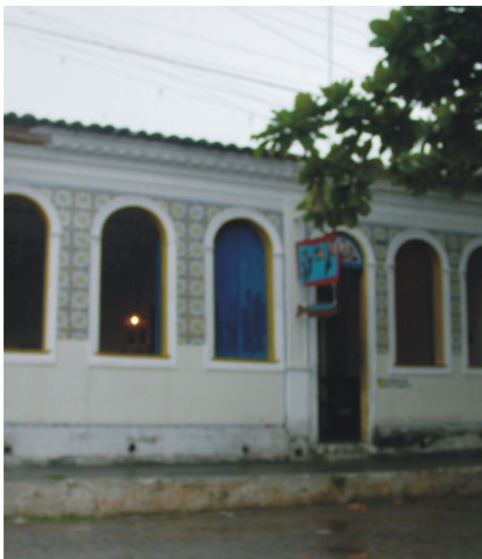
Figura 5.3.6-4 – Casa à Praça Dr. Imbassahi, nº 8
