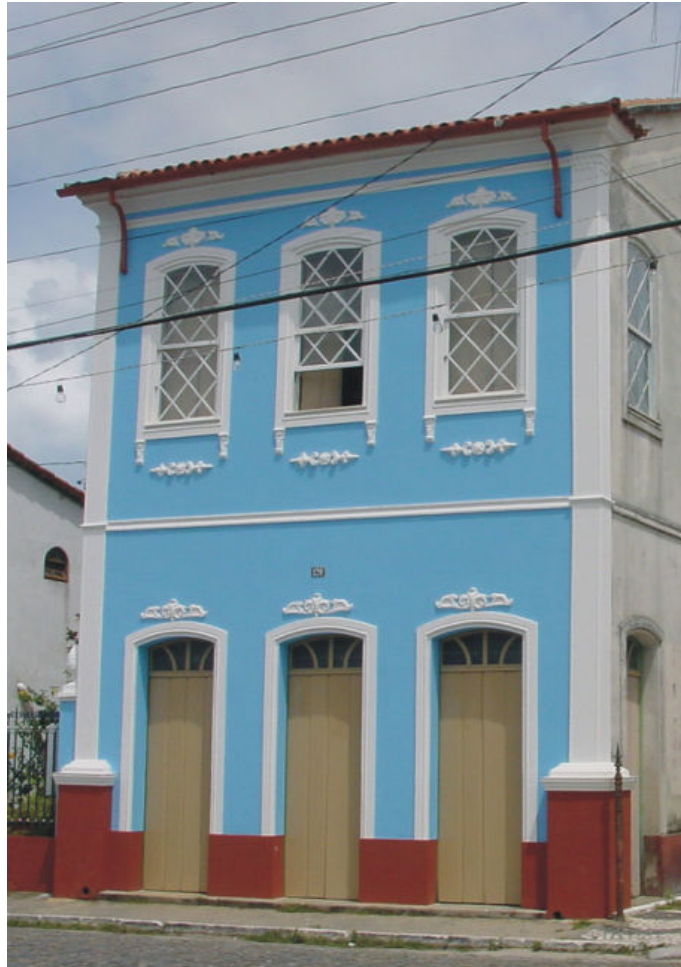
Figura 5.3.6-7 – Sobrado à Rua Barão do Rio Branco, n° 120
