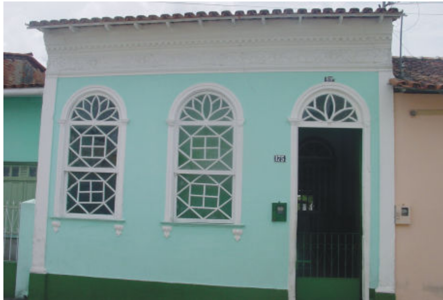
Figura 5.3.6-8 – Casa à Rua Firmino Pereira, n° 175
