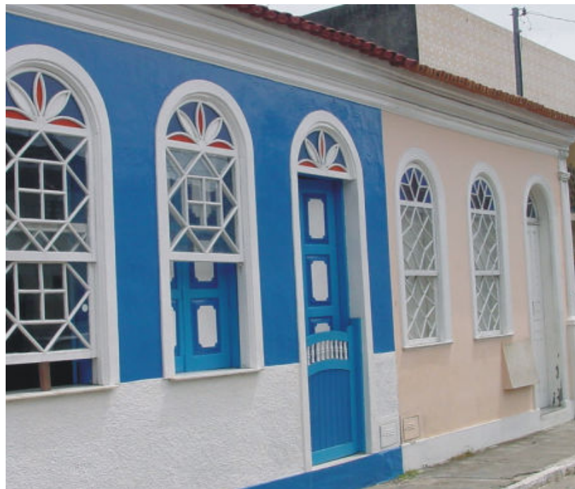
Figura 5.3.6-6 – Casa à Rua Barão do Rio Branco, nº 56/58
