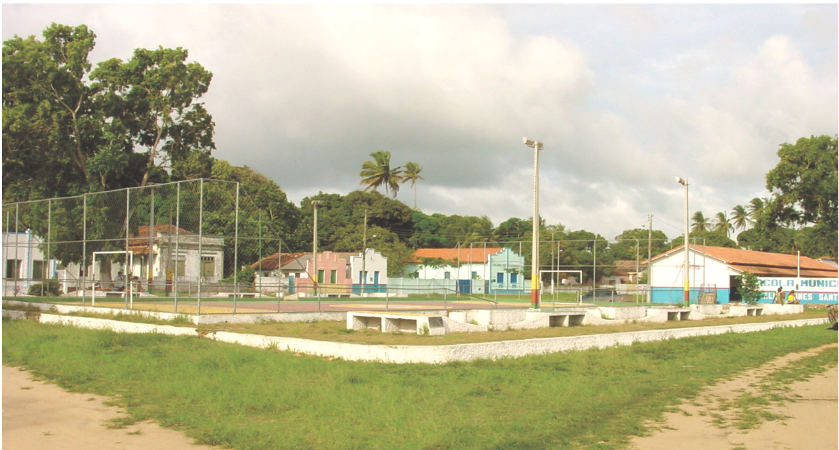
Figura 5.3.3-11 – Vista do Núcleo Dinâmico de Ponta de Areia
