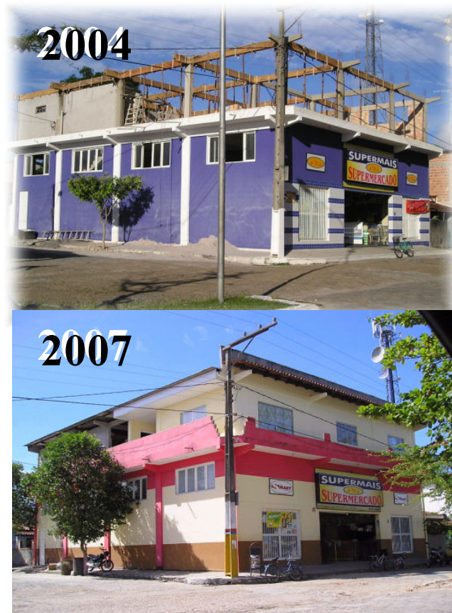
Figura 5.3.4-29 – Reforma realizada em um estabelecimento comercial de Caravelas
