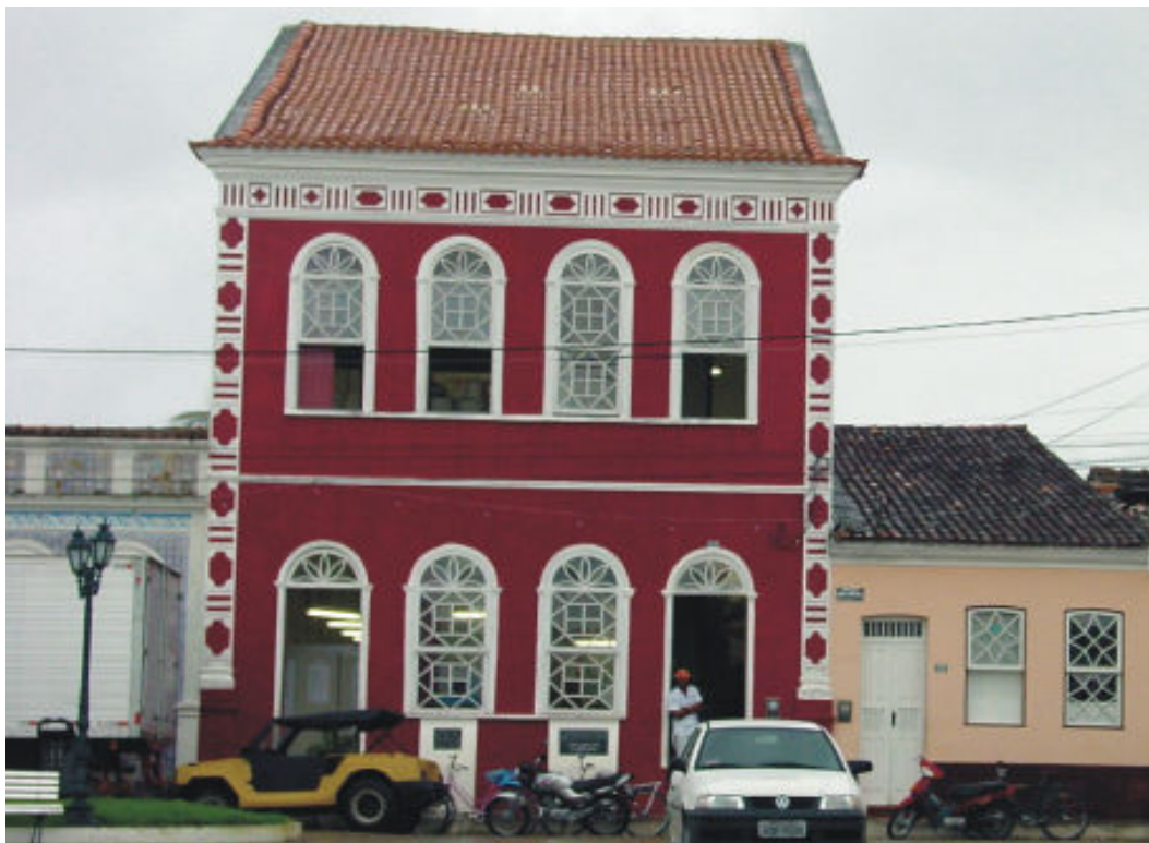
Figura 5.3.6-14 – Sobrado Praça Santo Antônio nº 28
