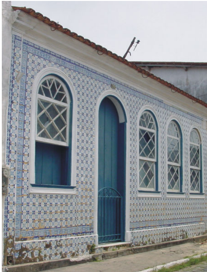
Figura 5.3.6-3 – Casa à Rua Barão do Rio Branco, nº 76
