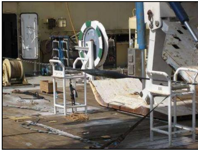
Figura III-5 - Exemplo de junção do cabo submarino, realizada a bordo do navio de instalação
