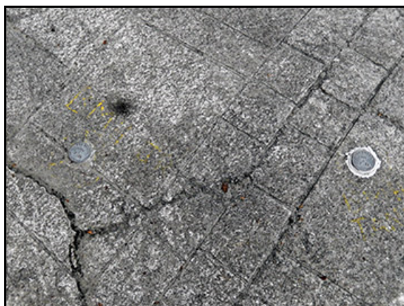
Figura V.3-3 - Duas caixas de passagem ( Beach Manhole - BMH), na calçada da orla do Bairro Caiçara.
