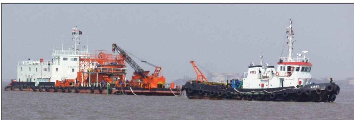
Figura III-8 - Exemplo de embarcações (barcaça/rebocador) utilizados na instalação do cabo submarino em zonas rasas (do limite da praia até lâmina d'água 15 m).
