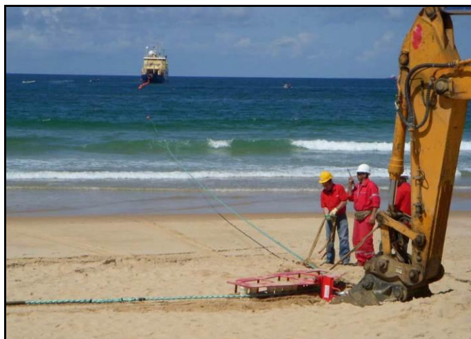
Figura III-26 - Uso do quadrante para a tração do cabo submarino na faixa de areia
