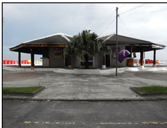
Figura V.3-4 - Vista de quiosques localizados próximos ao ponto de chegada do cabo, no Bairro Caiçara.
