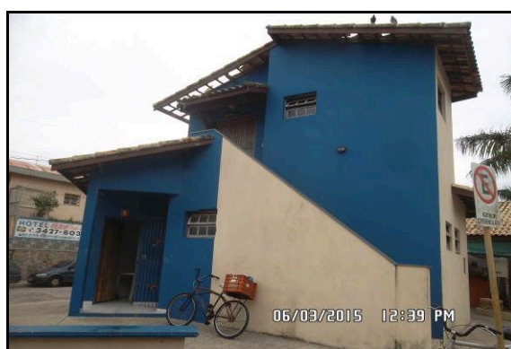
Figura V.3-32 - Foto com vista para o prédio da sede da Colônia Z-13 de Pescadores em Itanhaém
