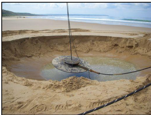
Figura III-28 - À esquerda - OGB (placa de aterramento), à direita - Obras de instalação do OGB
