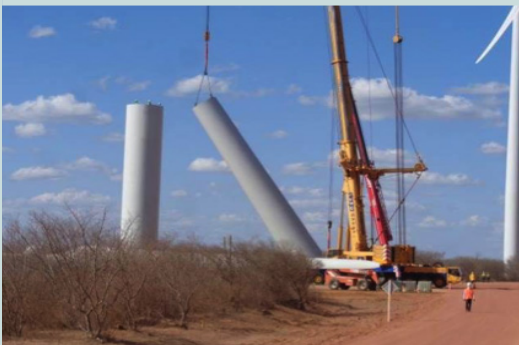
Montagem do segundo seguimento da torre
