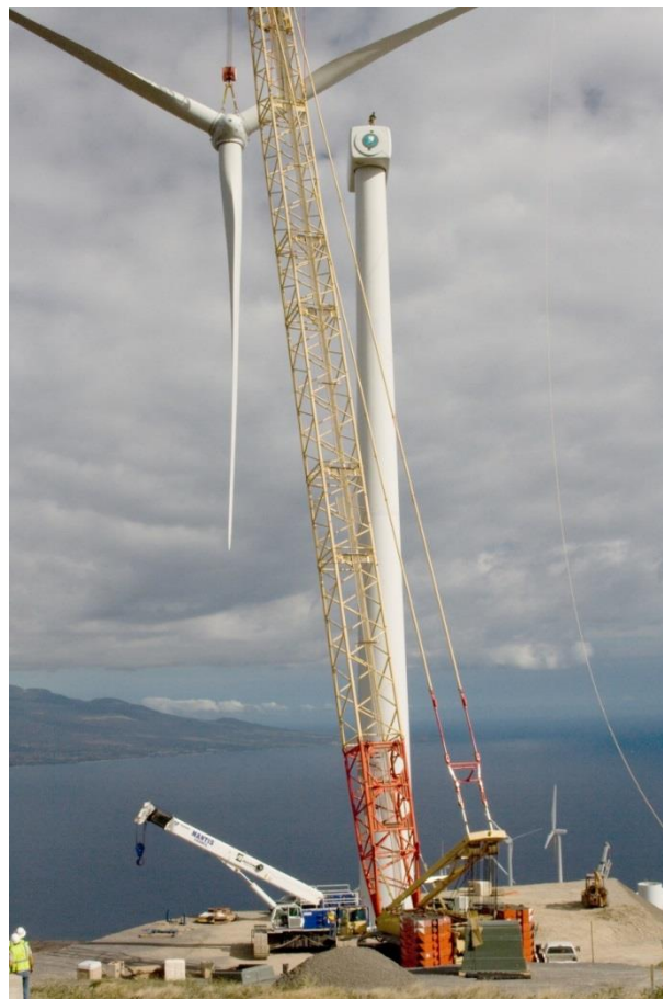
Figura 2.31 - Montagem das Pás Modalidade Multiple Blade (FONTE: Machine Market)
