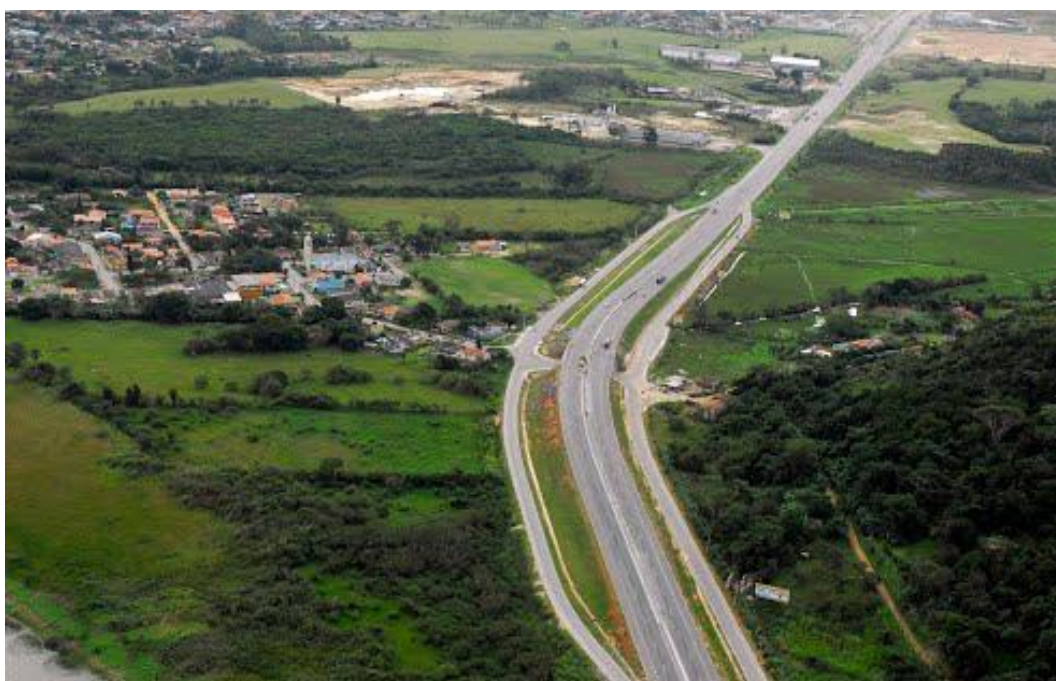
Figura 2.24 - Rodovia BR-101, trecho próximo à Imbituba-SC
