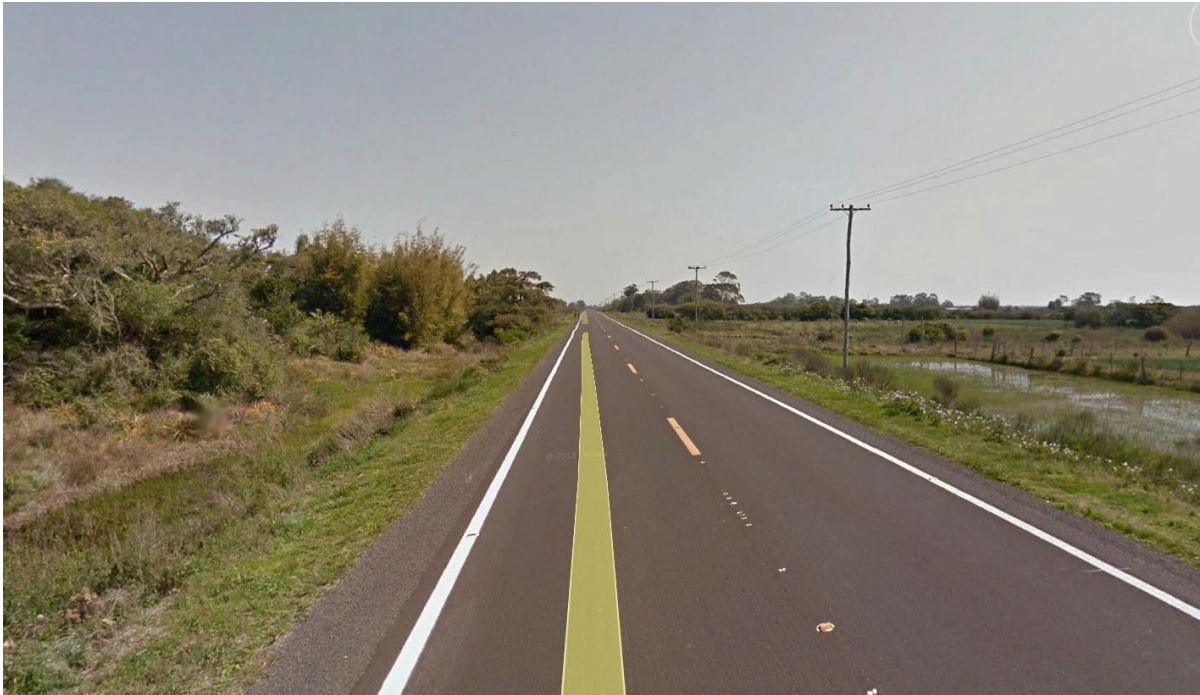
Figura 2.27 - Rodovia BR-101, trecho compreendido entre o distrito de Bojuru e a Cidade de São Jose do Norte – RS
