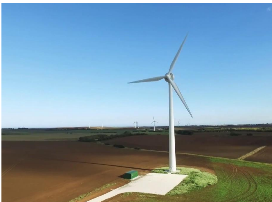
Figura 2.29 - Área do da Base para o Guindaste localizada a frente do aerogerador
