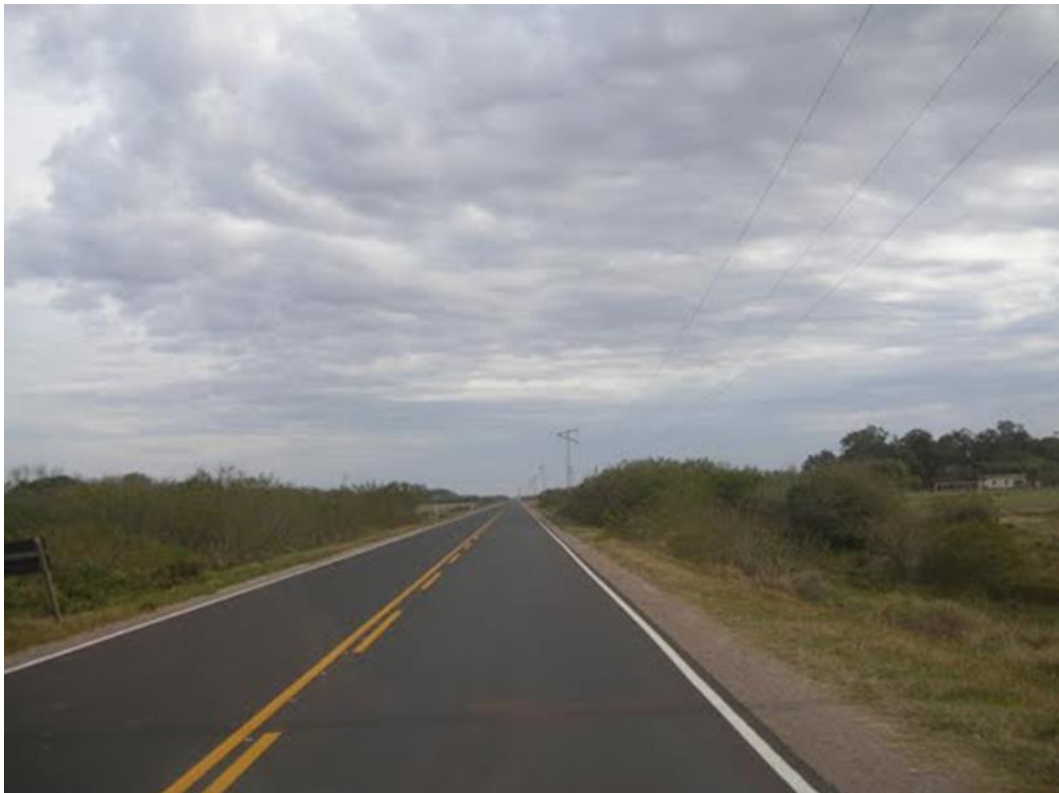
Figura 2.26 - Rodovia BR-101, trecho compreendido entre Osório-RS e Mostardas-RS
