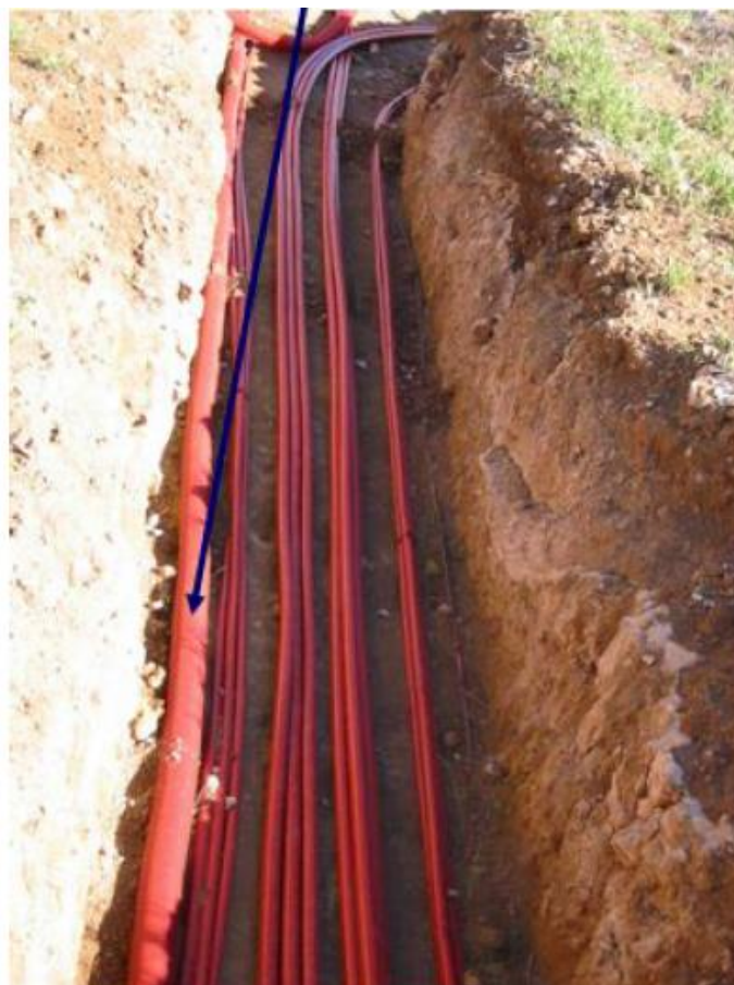
Figura 2.17 - Vala para Rede Elétrica Subterrânea. Fonte: [14]
