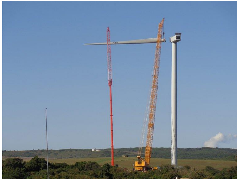
Figura 2.30 - Montagem das Pás, modalidade Single Blade (FONTE: Machine Market)
