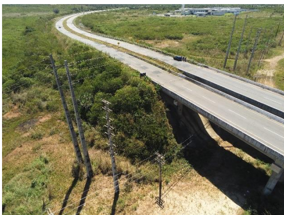
Foto 15 - Rede de Alta e Baixa (Vista Instituto Federal Ceará)
