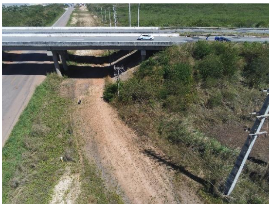
Foto 13 - Viaduto (Vista sentido Endesa)
