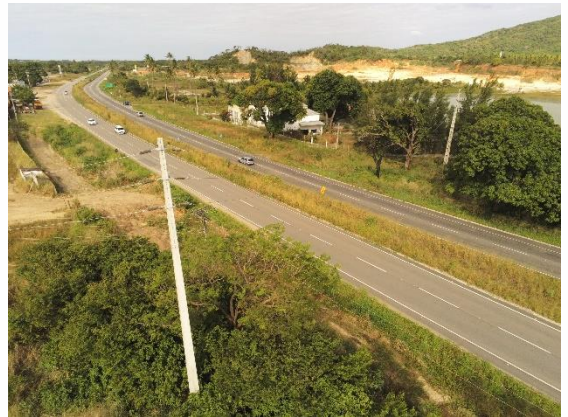
Foto 04 - Rede de Alta tensão Cruzando CE085
