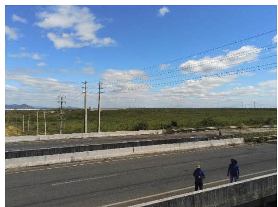
Foto 16F - Rede de Alta por cima do viaduto (Norte/Sul)
