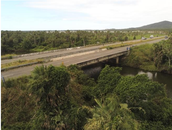
Foto 21 - Ponte sobre o Rio Cauípe
