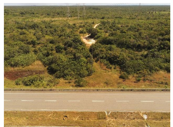
Foto 18B - Rede de Alta Tensão
