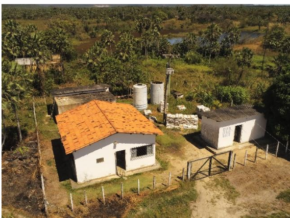
Foto 06 - Estação de Tratamento de água (Caucaia)
