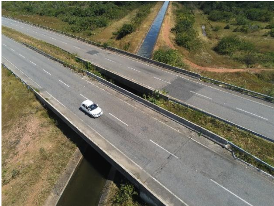
Foto 17 - EB Estação Bombeamento (Catuana para Zona de exportação Pecém ZPE)
