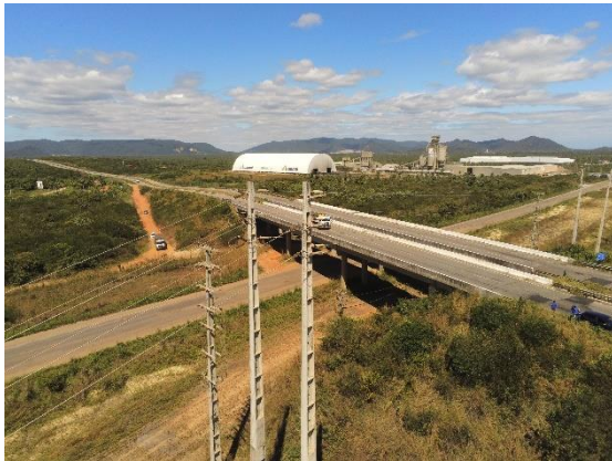
Foto 12 - rede de alta e baixa próximo viaduto CE085/CE422
