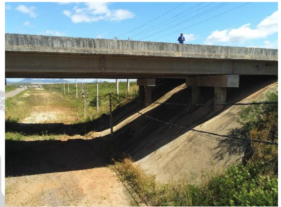
Foto 16D - Vista por baixo (Norte/Sul)
