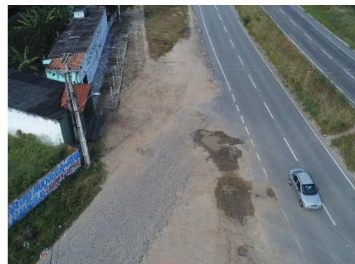
Foto 03 - Rede elétrica cruzando CE085
