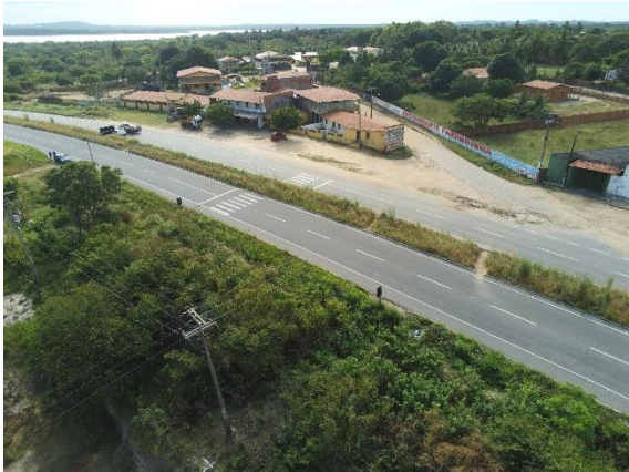
Foto 03A - Rede Elétrica Cruzando CE085
