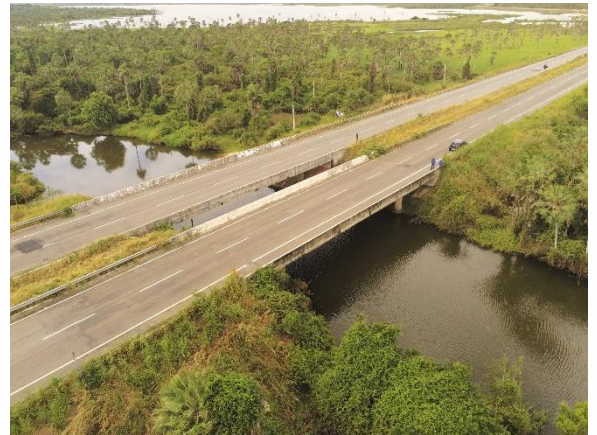
Foto 21A - Ponte sobre o Rio Cauípe
