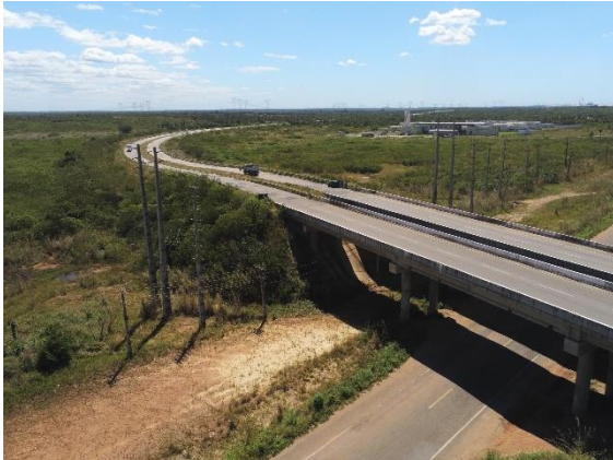
Foto 16A - Vista das redes de baixa tensão que passam por baixo do viaduto
