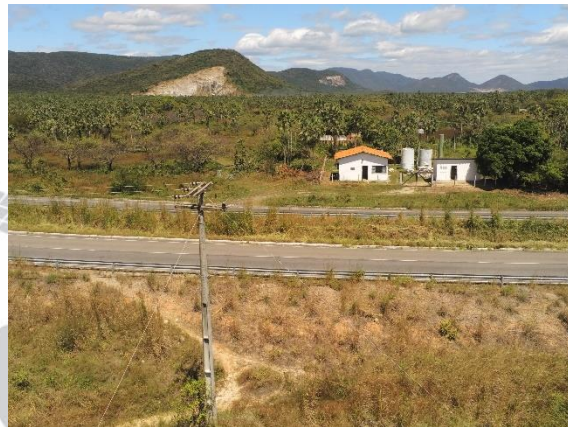
Foto 05 - Rede Elétrica Cruzando CE 085
