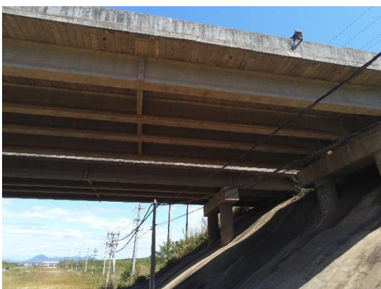
Foto 16E – Vista das Vigas do viaduto (Norte/Sul)
