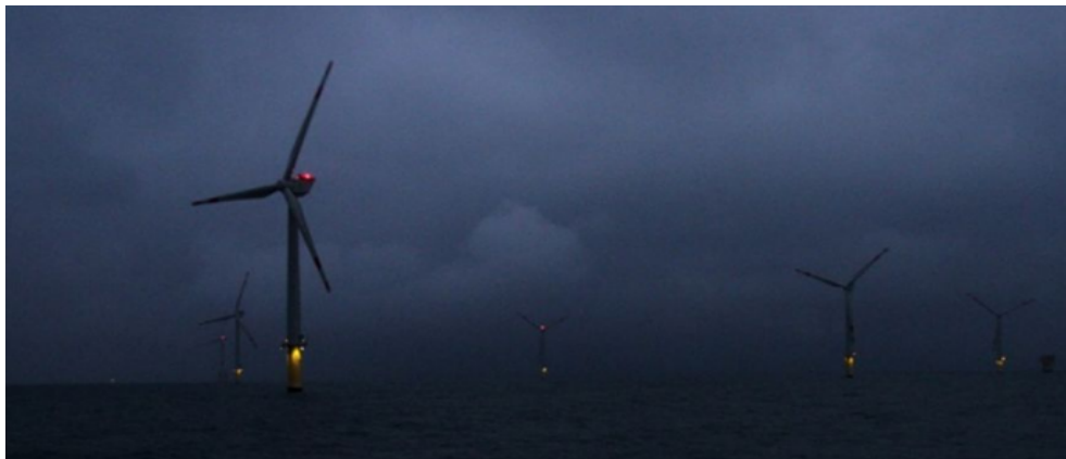
Figura 40 Exemplo de usina eólica offshore com sinal luminoso no topo da turbina e no elemento de transição, para navegação aérea e marítima.
