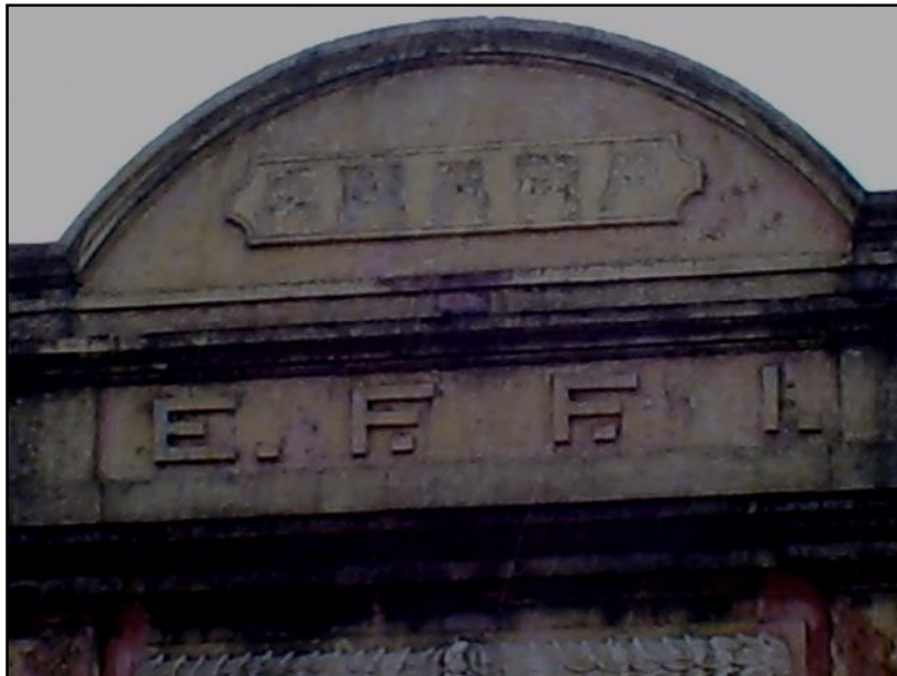
Figura 4.3.9.22- Inscrições na fachada superior da estação ferroviária.
