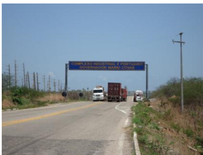
Figura 4.3.3.32: Via de acesso para o complexo industrial e portuário do Pecém.
