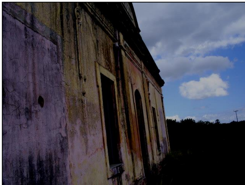
Figura 4.3.9.20- Detalhes dos compartimentos da estação ferroviária.
