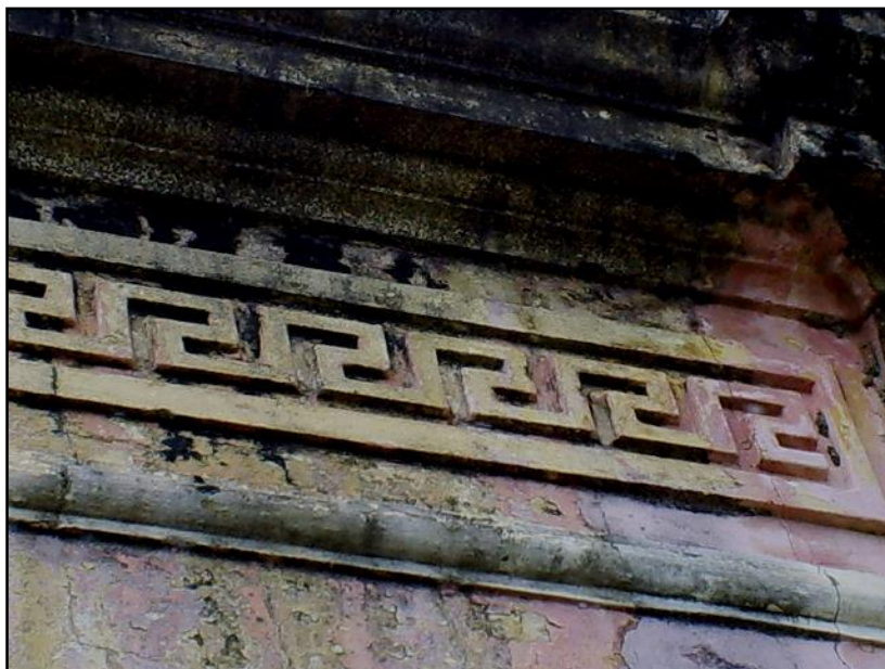
Figura 4.3.9.21 - Detalhes do adorno da fachada da Estação Ferroviária.
