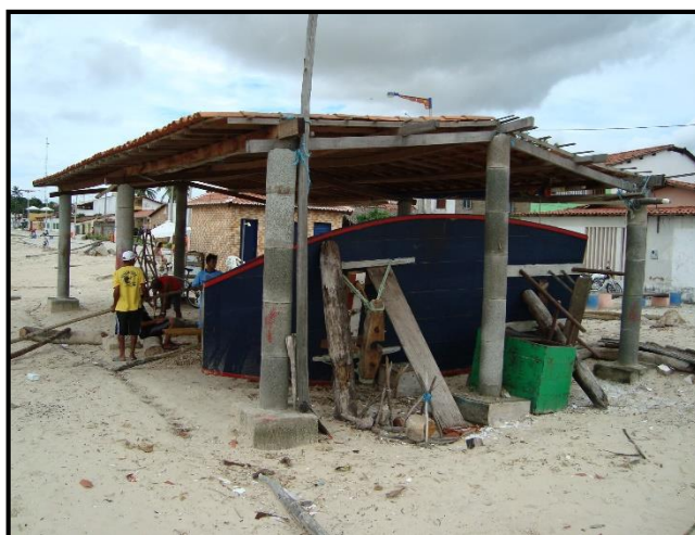
Figura 4.3.9.37: Galpão com uma jangada em construção.
