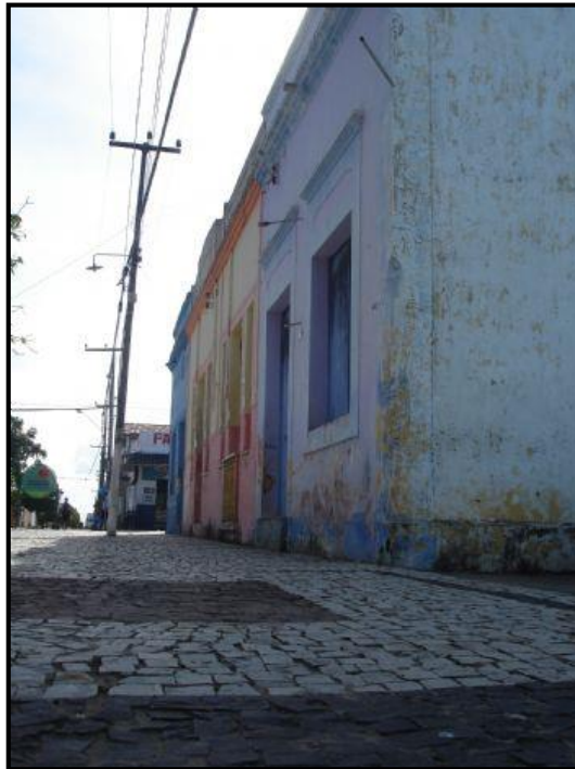
Figura 4.3.9.41: Edificações no Largo da Matriz.
