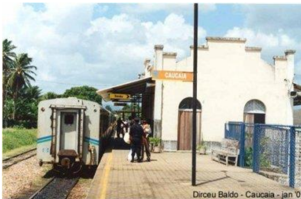
Figura 4.3.3.6 - Estação ferroviária de Caucaia
