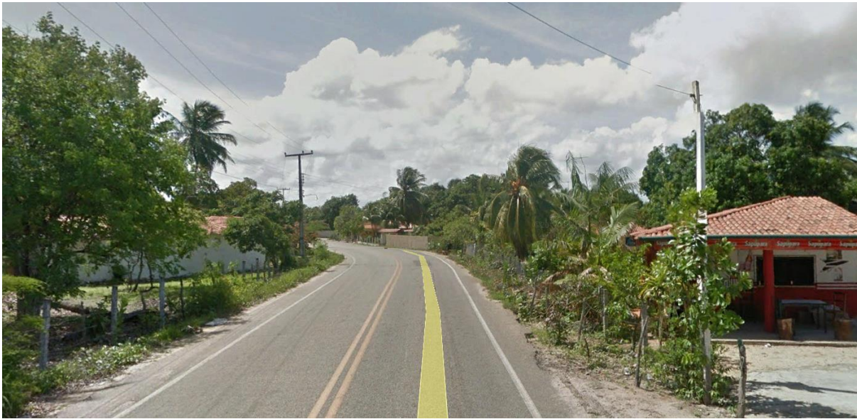
Figura 4.3.3.24: Infraestruturas presentes no território.
