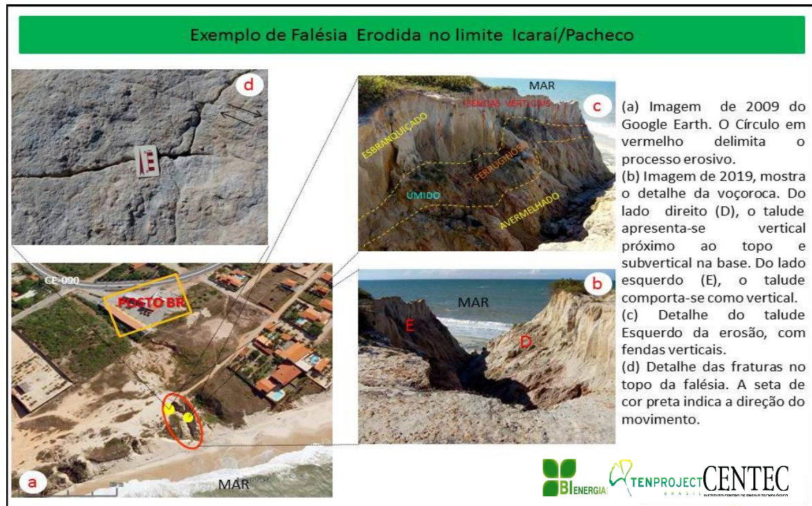
Figura 4.1.4.5.3 - Processo erosivo na falésia viva no limite Icaraí/Pacheco.
