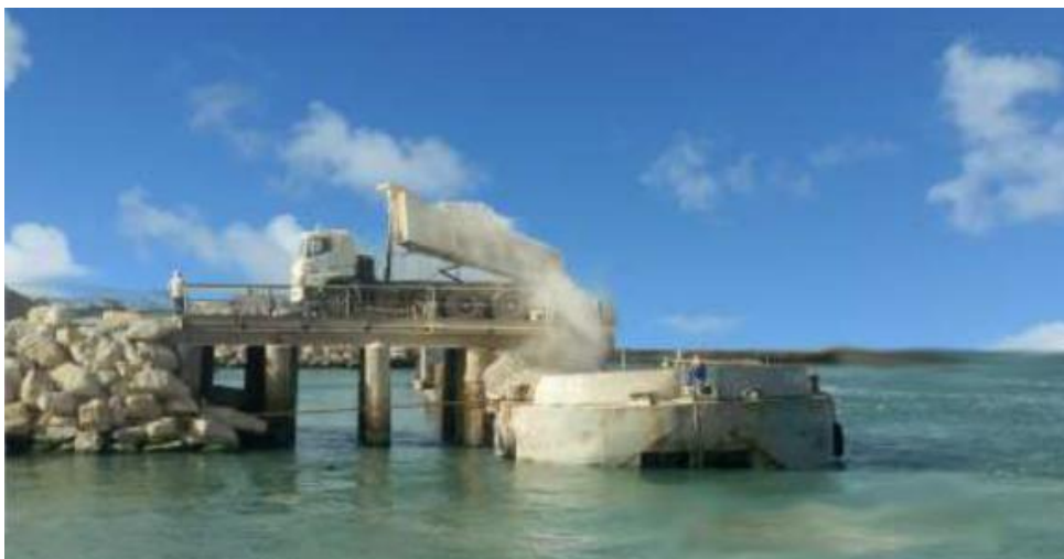
Figura 2.5.2.1.51 - Realização do núcleo com descarga de rochas do solo
