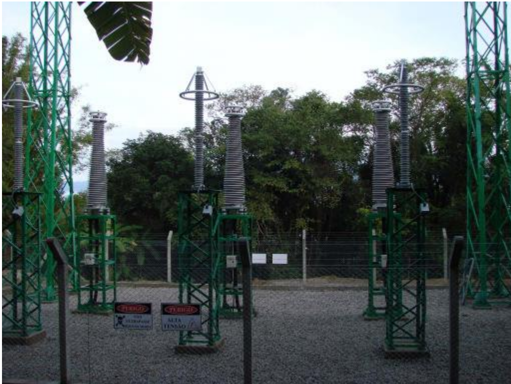
Figura 2.5.2.1.46 - Transição de rede subterrânea para linha aérea
