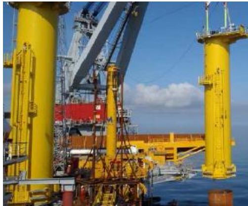
Figura 2.5.2.1.90 - Elevação da peça (junta) de transição.
