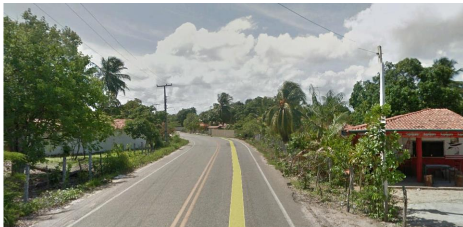
Figura 2.5.6.11 - Infraestruturas presentes no território
