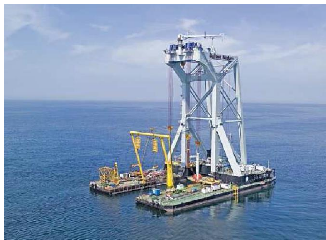
Figura 2.5.2.1.92 - Montagem da peça (junta) de transição com um navio guindaste.
