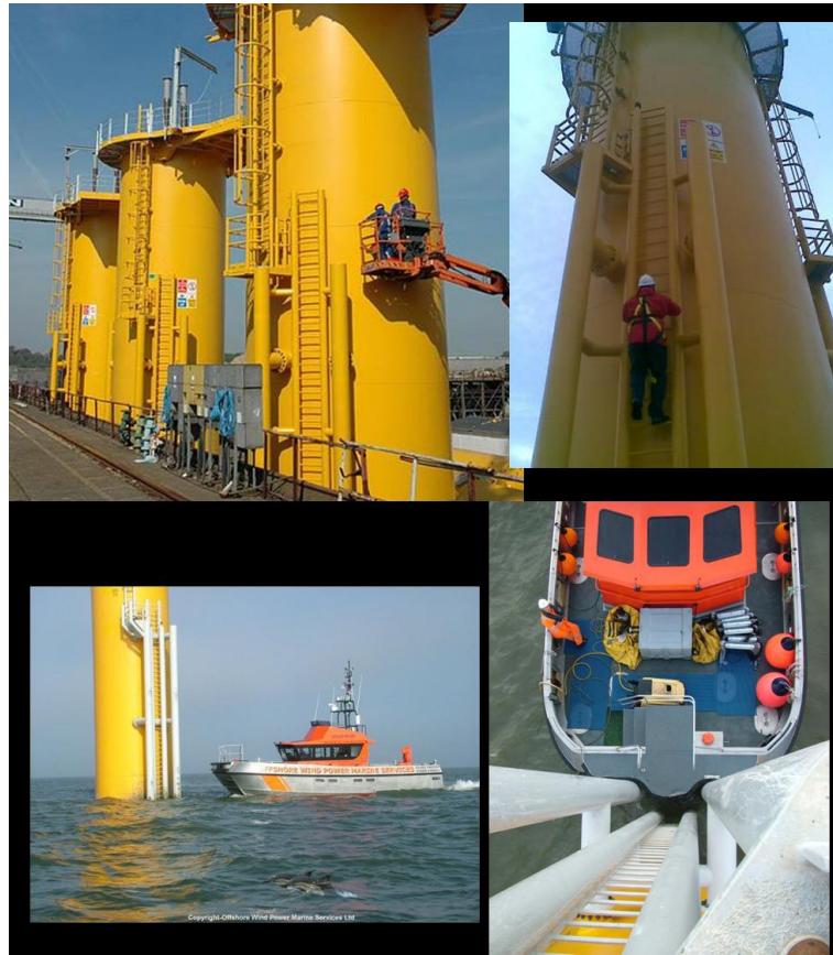
Figura 2.5.2.1.93 - Módulos de transição.
