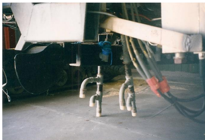
Figura 2.5.2.1.44 - Equipamento para escavação de vala em solo submarino arenoso
