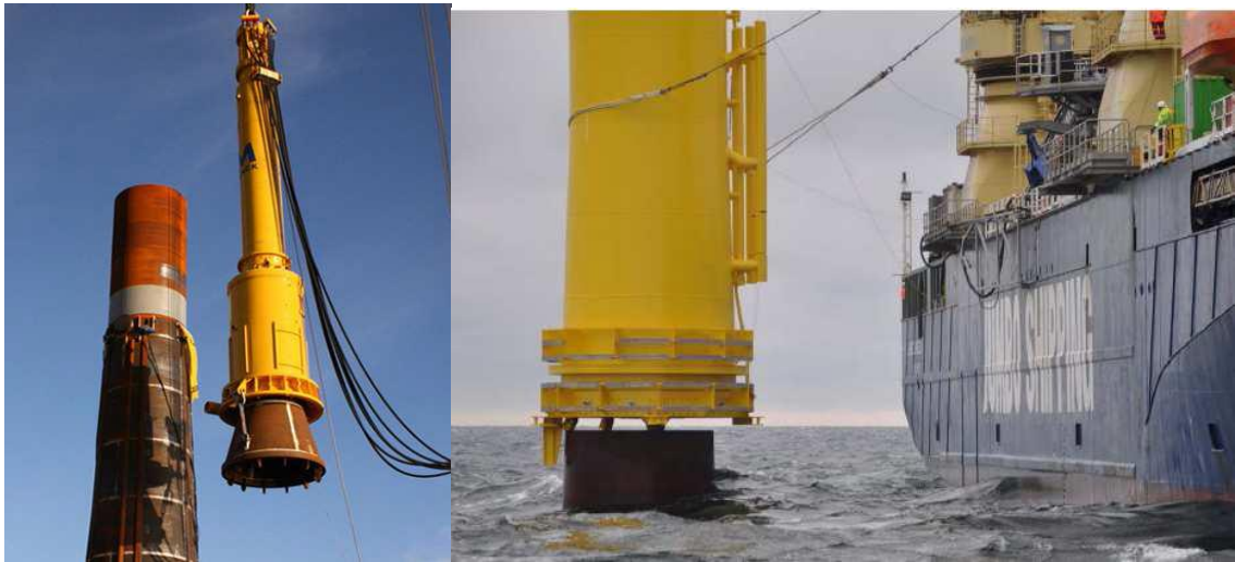
Figura 2.5.2.1.86 - Sino / Adaptador para elevação e instalação da fundação.
