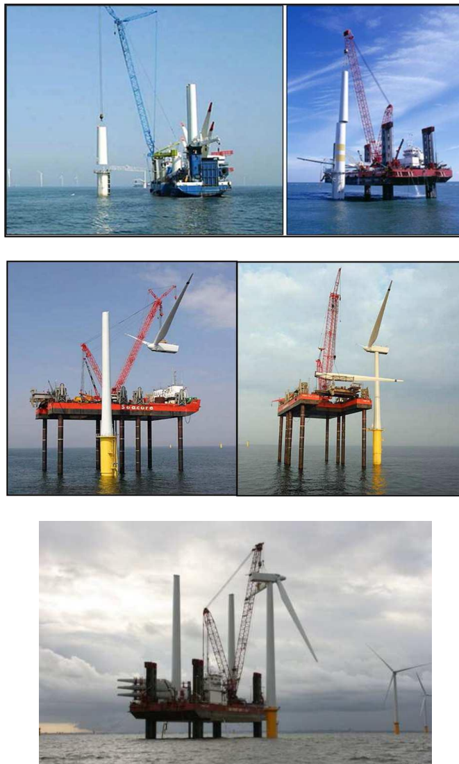
Figura 2.5.2.1.98 - Montagem das turbinas com jack-up.
