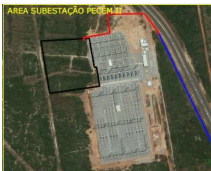
Figura2.1.7 – Área da subestação Pecém II
