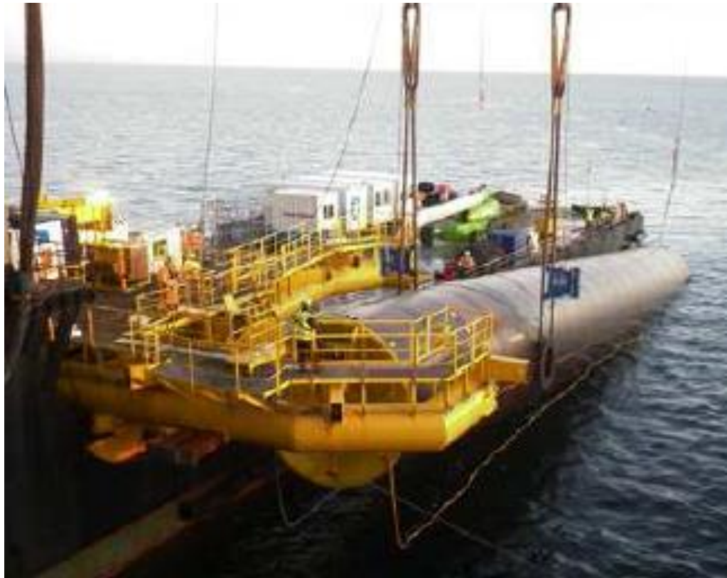
Figura 2.5.2.1.83 - Exemplo de transporte monopile com embarcação
