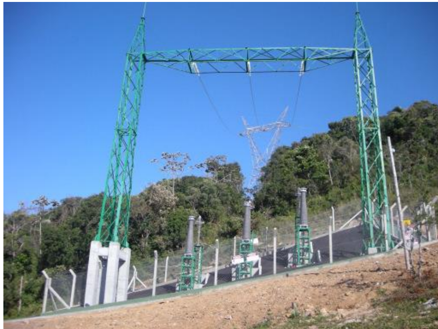
Figura 2.5.2.1.45 - Transição de rede subterrânea para linha aérea
