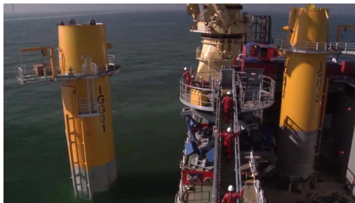
Figura 2.5.2.1.91 - Posicionamento da peça (junta) de transição.
