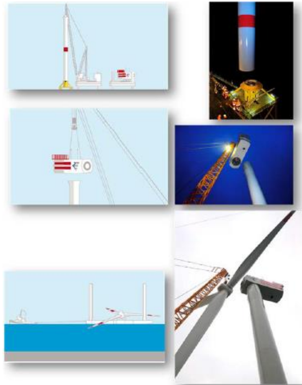
Figura 2.5.2.1.94 - Esquema tipológico de montagem da turbina
