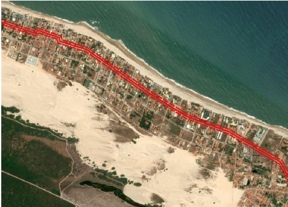
Figura 2.5.2.1.7 - Detalhe do duto de cabo ao redor com tracejado do polígono considerado
