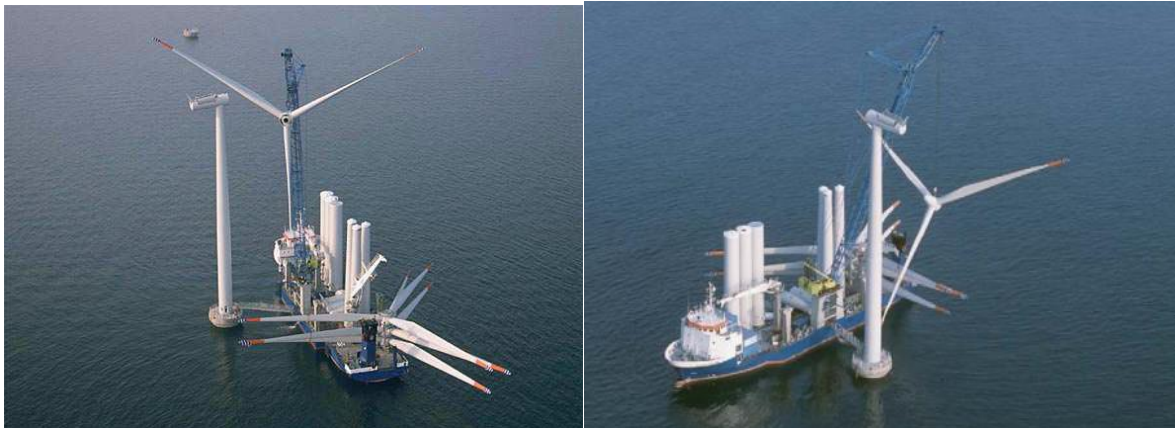
Figura 2.5.2.1.96 - Montagem com navio guindaste.
