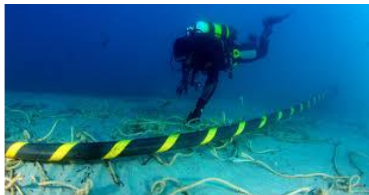
Figura 2.5.2.1.36 - Acompanhamento do cabo por mergulhadores
