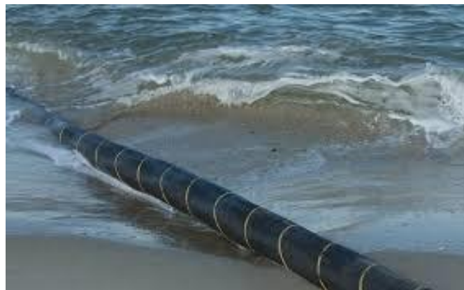
Figura 2.5.2.1.35 - Chegada cabo submarino na praia
