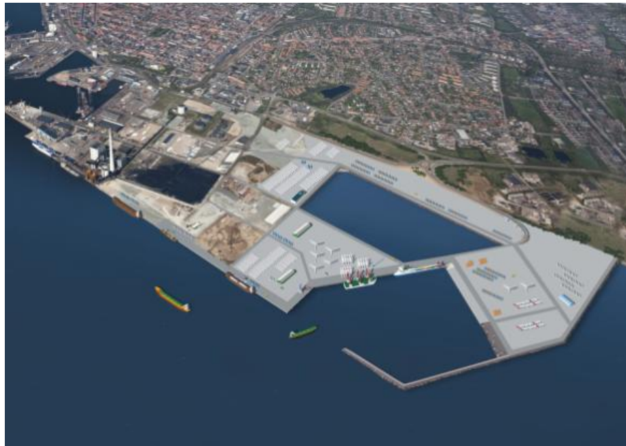
Figura 2.5.2.1.24 - Representação relacionada ao uso do porto de Esbjerg na Dinamarca, para parque offshore.
