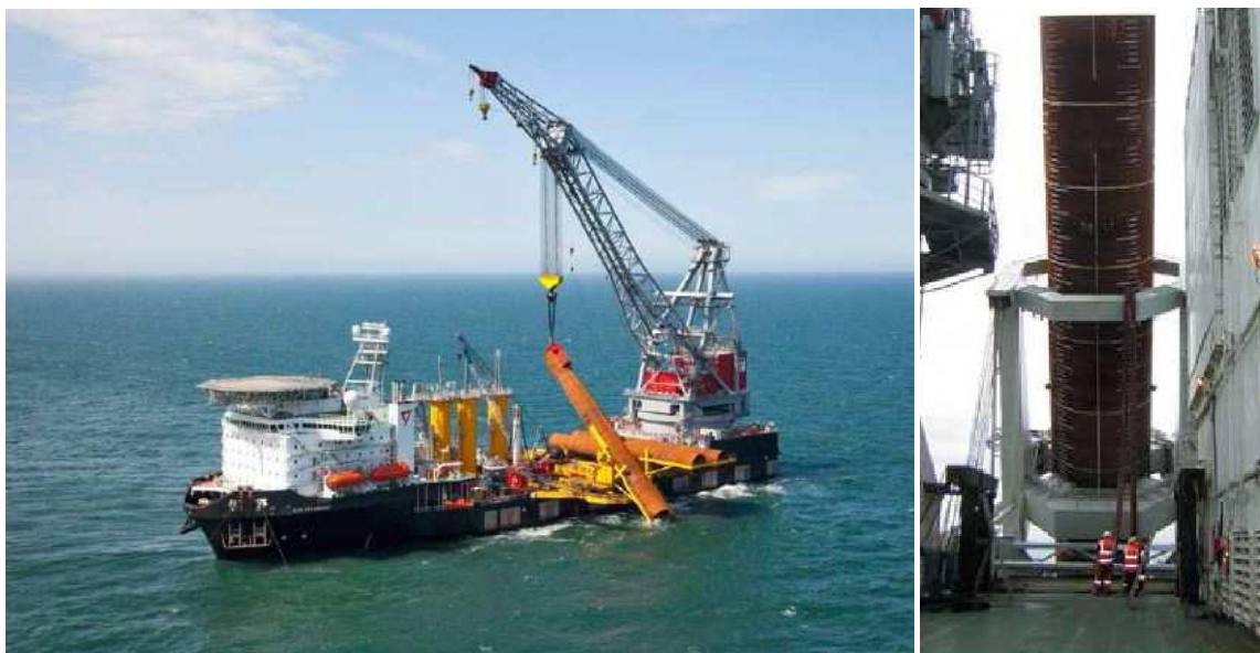
Figura 2.5.2.1.85 - Elevação e posicionamento do monopile.
