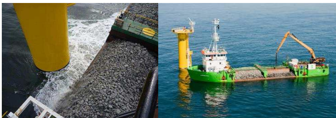
Figura 2.5.2.1.76 - Posicionamento das rochas com as conchas, na barcaça de transporte.
