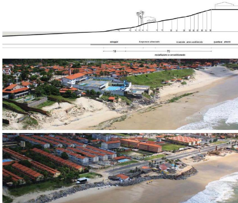
Figura 2.5.1.1.2.4.5.3 - Fenômeno da erosão tipo B.
