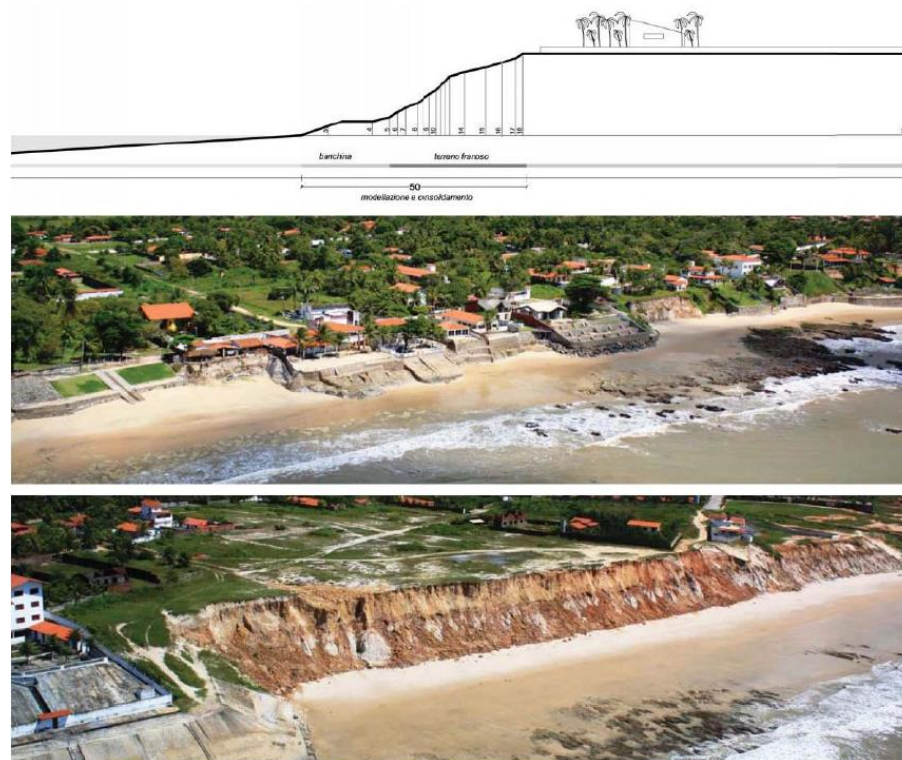
Figura 2.5.1.1.2.4.5.2 - Fenômeno da erosão tipo A.
