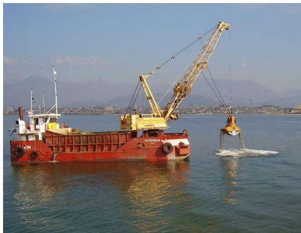
Figura 2.5.2.1.50 - Embarcações para construção dos molhes (drega e barcaça de transporte).
