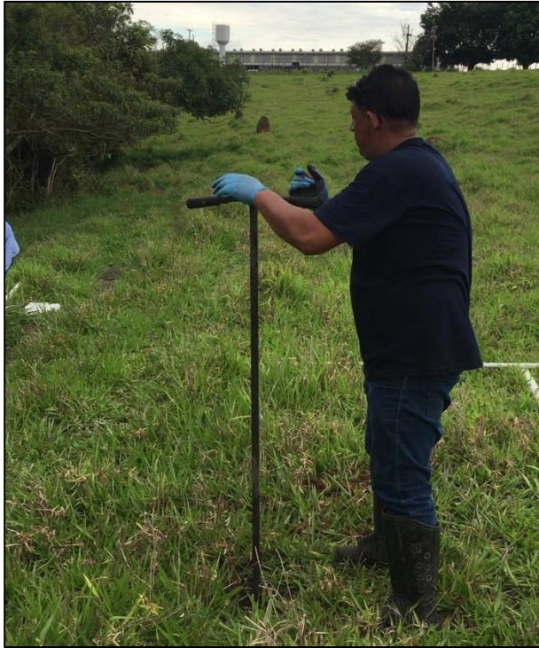
Figura 6.1.69 – Realização da perfuração do solo para instalação do PM-01
