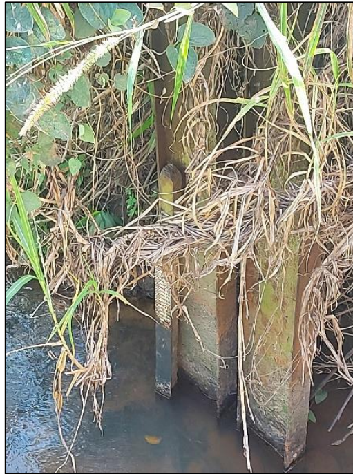
Figura 6.1.51 - Localização da antiga estação Cerâmica Quirino, no ribeirão Caçapava Velha
