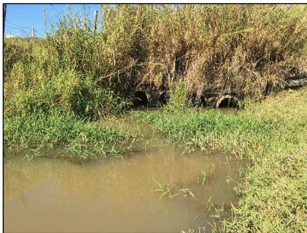
Figura 6.1.123 – Bueiro quintuplo à montante do Ponto Amostra 1, o qual possibilita a travessia no Ribeirão Caçapava Velha. Data: 26/05/2022.
