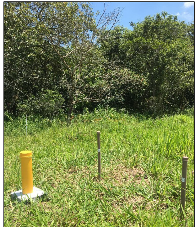
Figura 6.1.72 – Piezômetros e poço de monitoramento instalados
