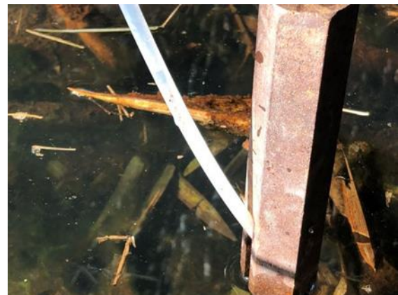
Figura 6.1.103 - Piezômetro diferencial mostrando a carga hidráulica da água subterrânea
