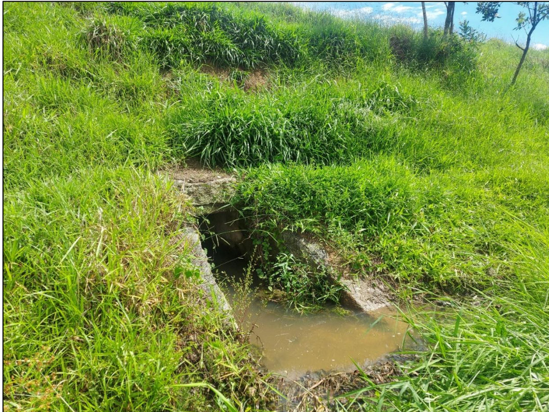
Figura 6.1.45 - Jusante do bueiro existente, sob o acesso, possibilitando a passagem do fluxo d'água proveniente do afloramento secundário
