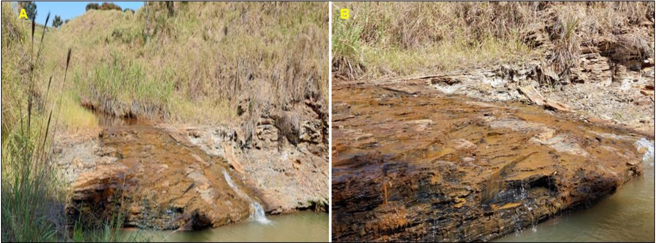
Figura 6.1.31 – (A) Ação da erosão por processo de escoamento de água. (B) Marcas de deslocamento e remobilização do material superficial.
