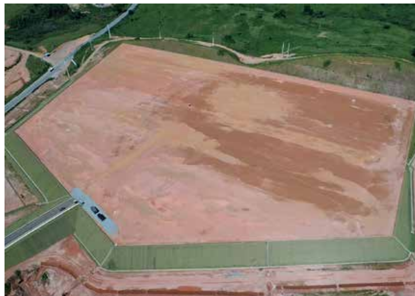
Vista aérea do terreno onde está sendo construída a UTE Marlim Azul I e onde está prevista a construção da UTE Marlim Azul II. Crédito: ARKE
