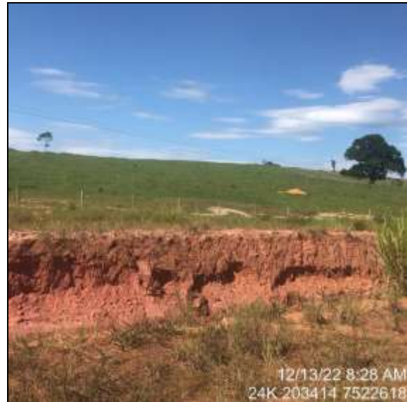
Figura 6.1-10 - Detalhe de corte com ocorrência de Latossolo Vermelho-Amarelo na AE.
