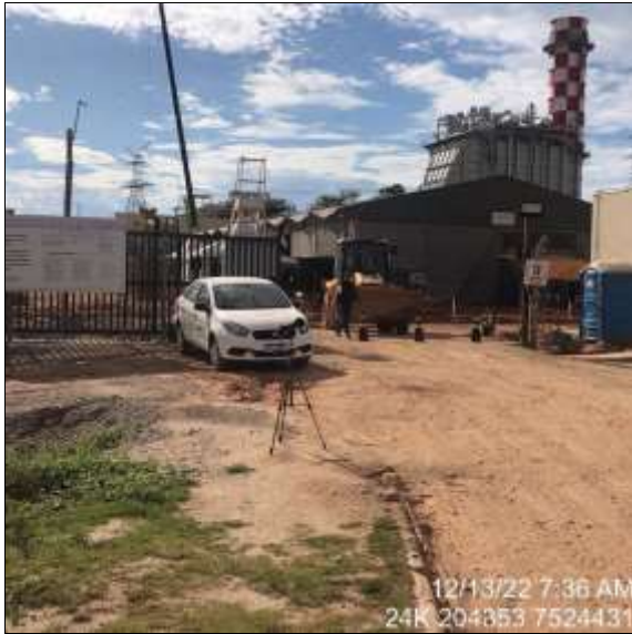
Figura 6.1-129 - Equipamento posicionado para aferição dos níveis de pressão sonora no NPS01 no período diurno.
