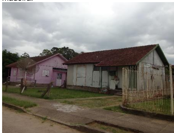
Foto 6.5-77 - Habitações unifamiliares de baixo padrão construtivo, com estrutura e vedação de madeira.
