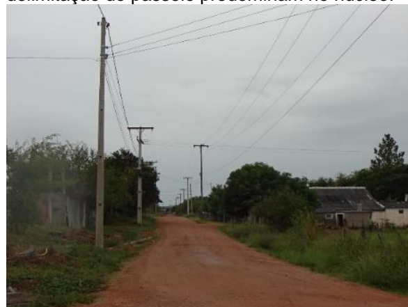
Foto 6.5-122 - As vias sem pavimentação ou delimitação do passeio predominam no núcleo.
