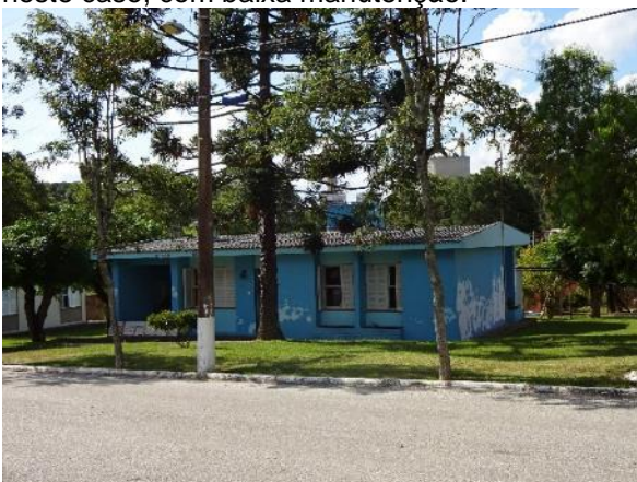
Foto 6.5-58 - Tipologia habitacional de maiores dimensões com médio construtivo, construída em alvenaria de tijolos rebocados e pintados, neste caso, com baixa manutenção.
