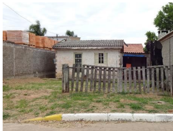
Foto 6.5-110 - Casa de baixo padrão construtivo, construída em alvenaria de tijolos chapiscados.
