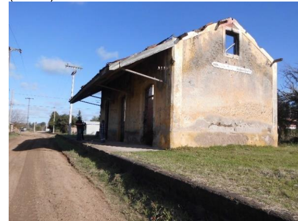
Foto 6.5-232 - Antiga Estação Santa Rosa (Seival) em ruínas.
