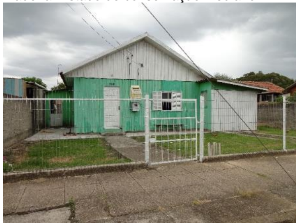
Foto 6.5-78 - Casa com baixo padrão construtivo, com estrutura e vedação de madeira. Estado de conservação mediano.
