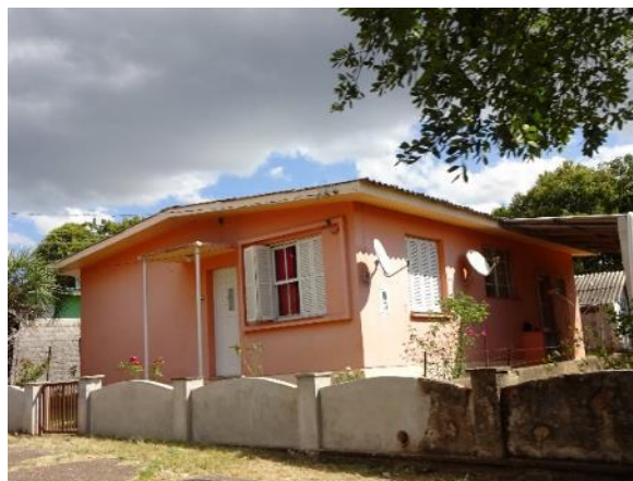
Foto 6.5-59 - Casa de médio padrão construtivo, construída em alvenaria de tijolos rebocados e pintados.
