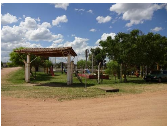
Foto 6.5-164 - Praça Principal de Hulha Negra.
