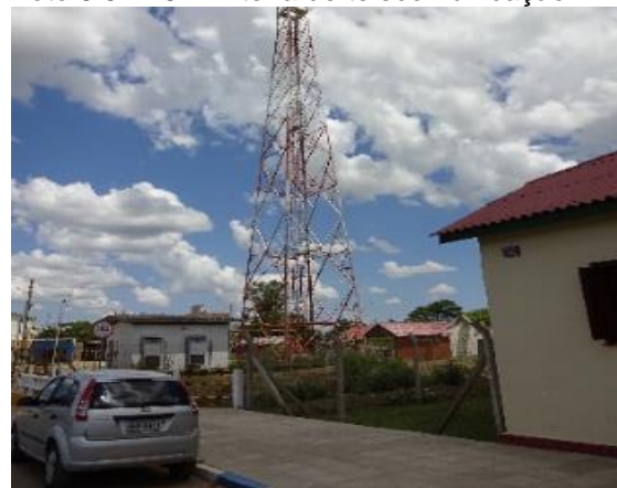
Foto 6.5-146 - Antena de telecomunicação.
