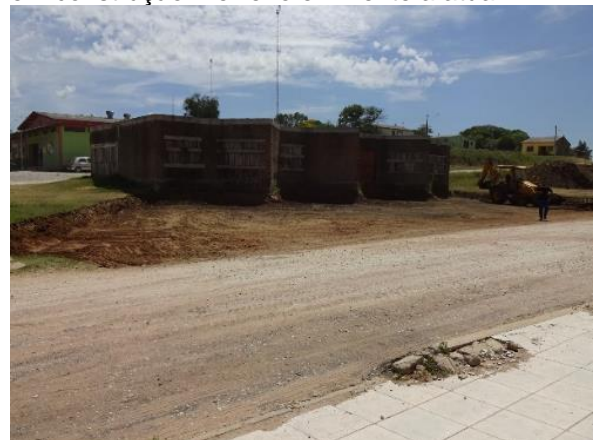
Foto 6.5-155 - Nova Rodoviária de Hulha Negra em construção. Terreno em frente a atual.
