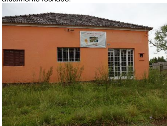
Foto 6.5-120 - Restaurante Cantina Santa Rosa, atualmente fechado.
