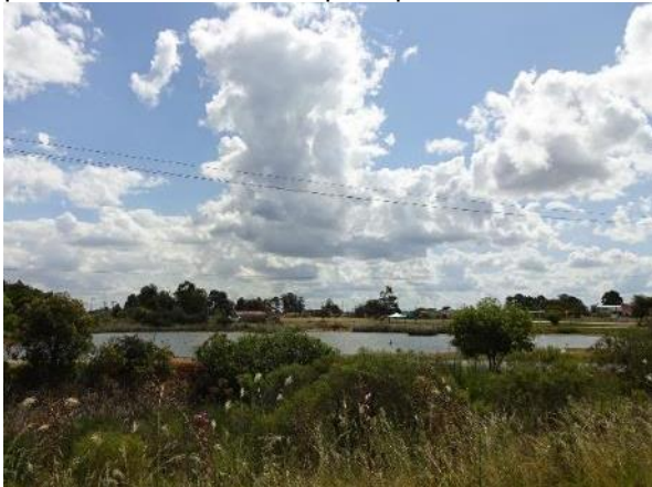
Foto 6.5-5 - Vista da barragem e do núcleo a partir da rótula da MAC, principal acesso.
