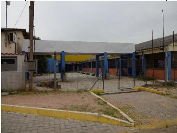
Foto 6.5-105 - Conjunto de prédios da Escola Municipal de Ensino Fundamental Neli Betemps.
