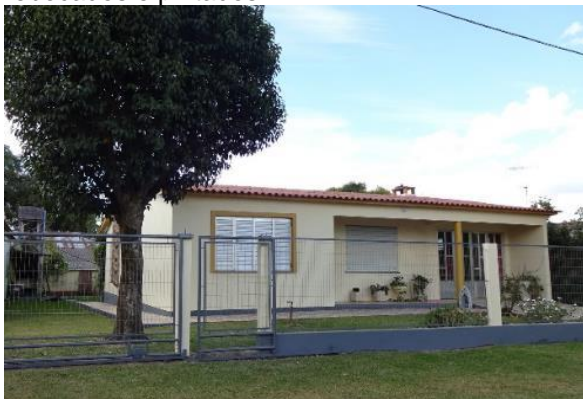
Foto 6.5-188 - Casa de médio padrão construtivo, construída em alvenaria de tijolos rebocados e pintados.
