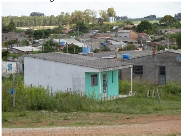
Foto 6.5-168 - Edificação residencial de baixo padrão construtivo em alvenaria (no primeiro plano). Ao fundo, domicílios construídos em alvenaria apenas chapiscados. Forte presença de caixas d'água.
