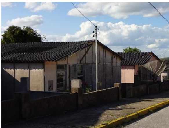
Foto 6.5-58 - Tipologia habitacional de maiores dimensões com médio construtivo, construída em alvenaria de tijolos rebocados e pintados, neste caso, com baixa manutenção.
