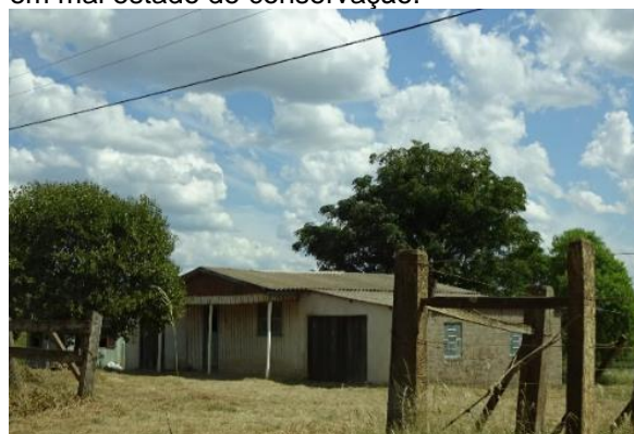
Foto 6.5-191 - Habitação com baixo padrão construtivo, construída em madeira e alvenaria, em mal estado de conservação.
