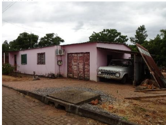
Foto 6.5-91 - Casa de médio-baixo padrão construtivo, construída em alvenaria de tijolos rebocados e pintados, com baixa manutenção - comprometendo o estado de conservação das aberturas.
