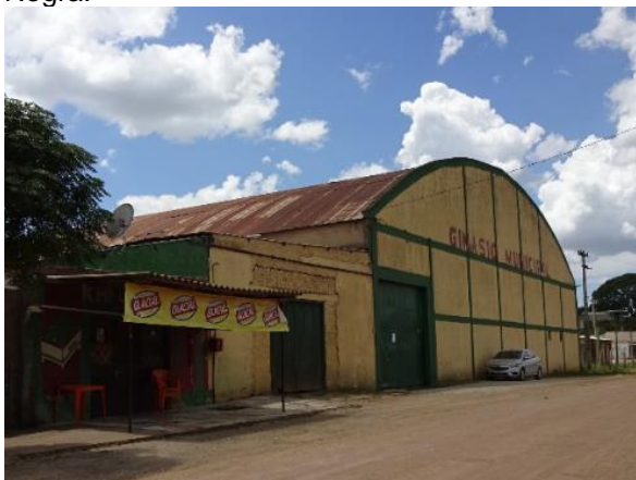
Foto 6.5-160 - Ginásio Municipal de Hulha Negra.
