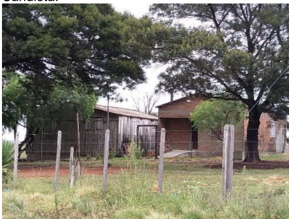
Foto 6.5-204 - Casa de Alvenaria sem Revestimento - Assentamento Estância Samuel / Candiota.
