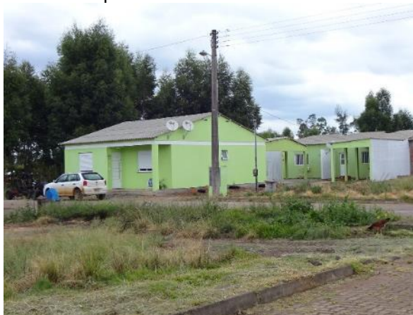
Foto 6.5-92 - Edificação com médio padrão construtivo, com estrutura mista e alvenaria rebocada e pintada.
