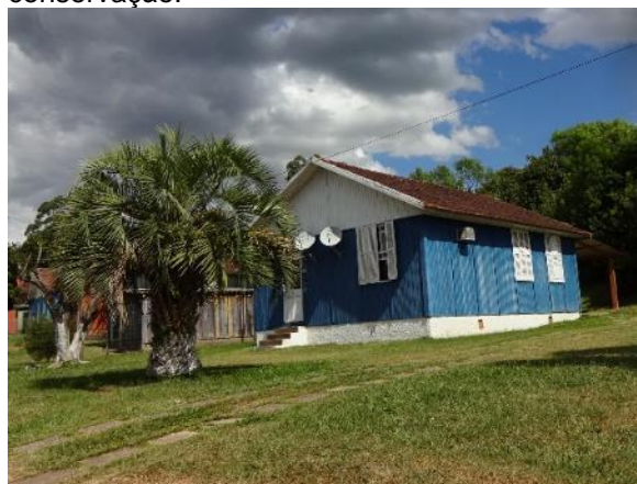
Foto 6.5-57 - Casa de médio-baixo padrão construtivo, com estrutura e vedação em madeira aparelhada em bom estado de conservação.
