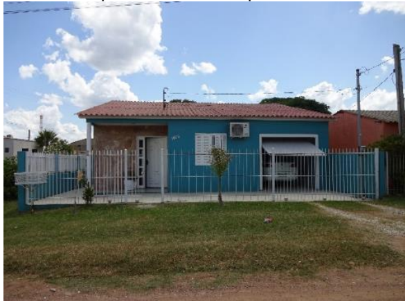
Foto 6.5-166 - Residência em alvenaria rebocada e pintada de médio padrão construtivo.
