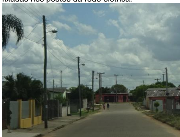
Foto 6.5-16 - Iluminação pública: luminárias fixadas nos postes da rede elétrica.
