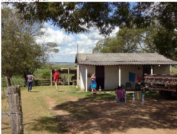
Foto 6.5-202 - Casa de Alvenaria com Revestimento - Assentamento Estância Samuel / Hulha Negra.
