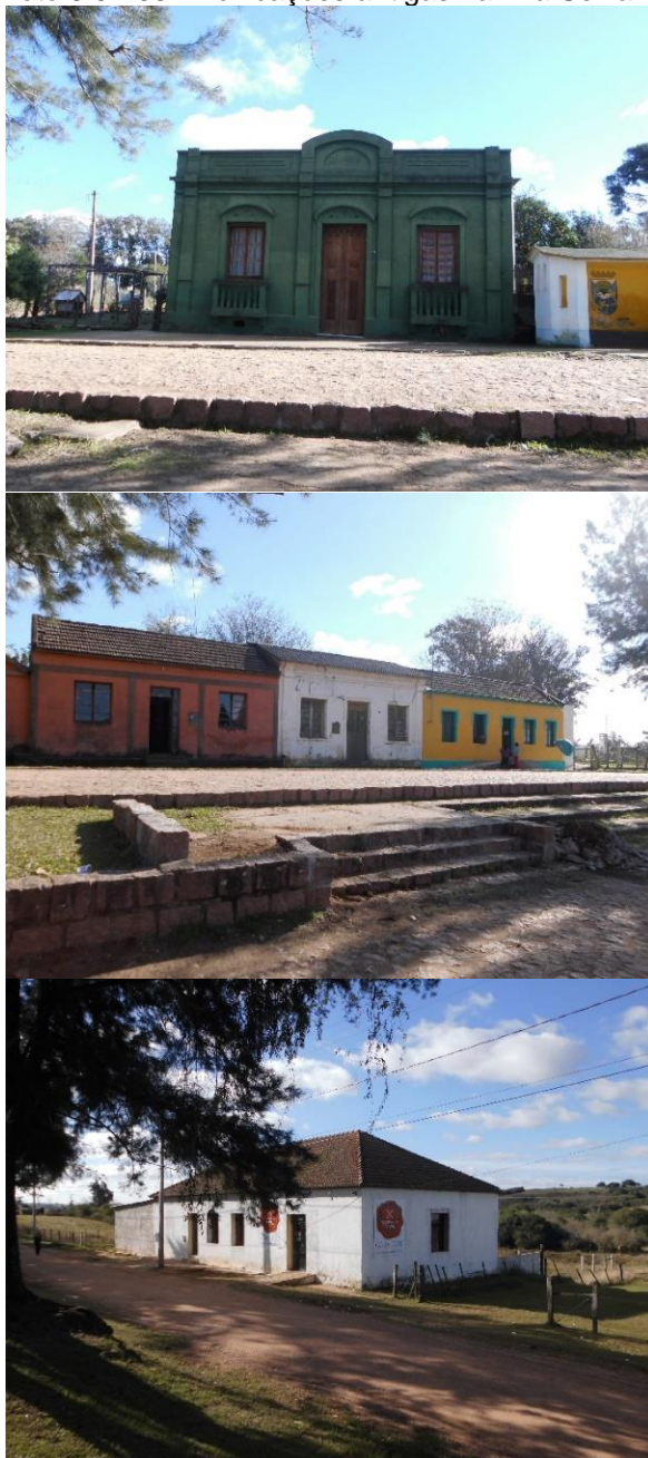
Foto 6.5-233 - Edificações antigas na Vila Seival.
