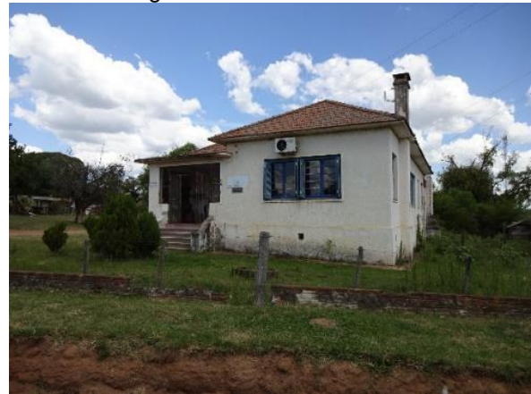
Foto 6.5-153 - Escritório Municipal Emater/RS em Hulha Negra.
