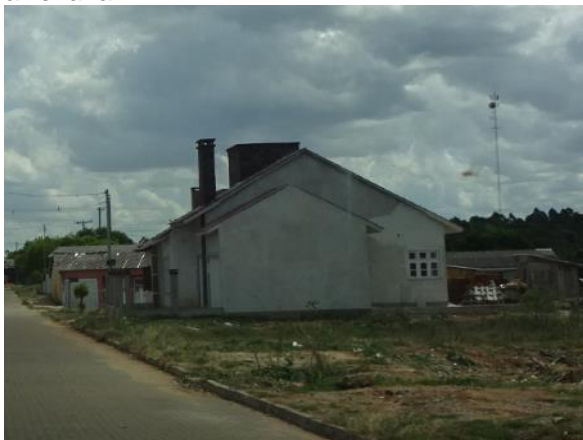
Foto 6.5-30 - Edificação residencial (em construção) de médio padrão construtivo em alvenaria.
