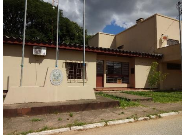
Foto 6.5-43 - Edificação do 4º Pelotão da Brigada Militar de Candiota, recentemente reformado.
