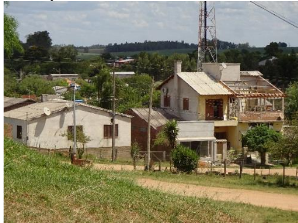
Foto 6.5-167 - Casa de dois pavimentos em construção na sede.
