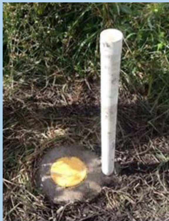
Poço de monitoramento instalado para UTE Nossa Senhora de Fátima
