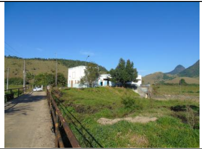
Estrutura de Captação da CEDAE
