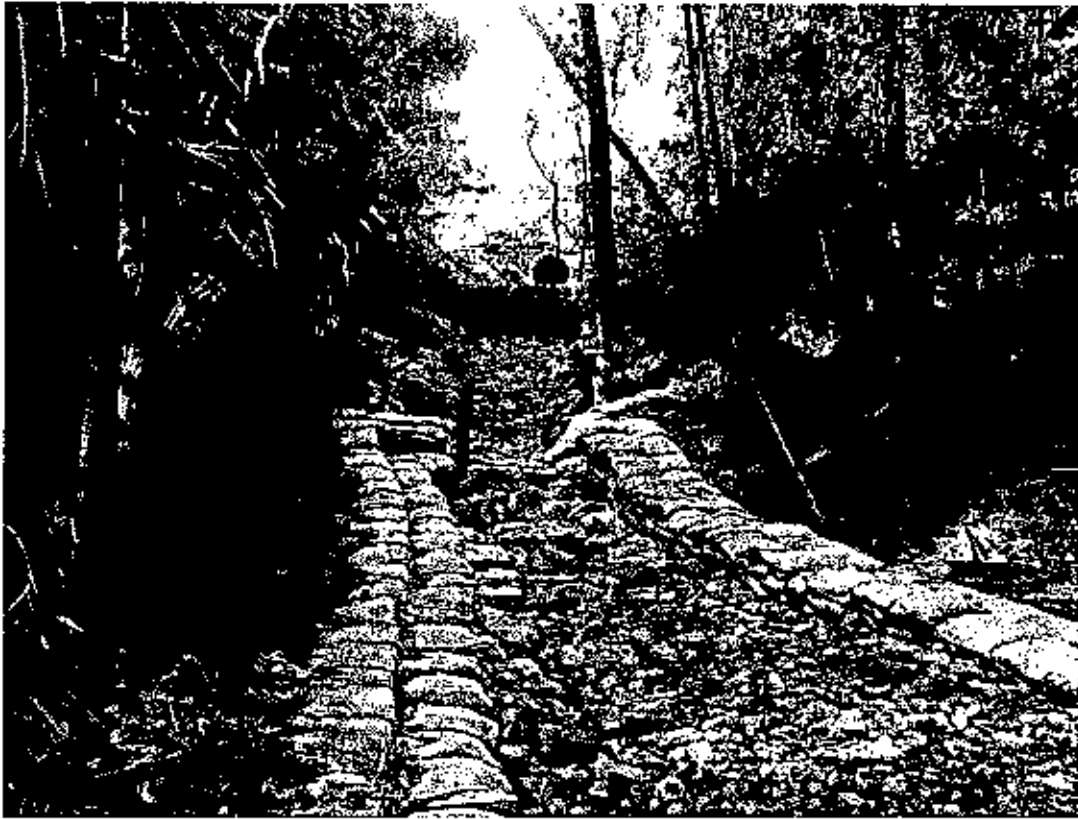
Figura 23- Drenagem UTE lado oeste
