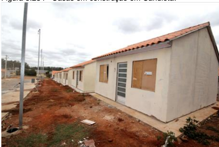
Figura 5.234 - Casas em construção em Candiota.
